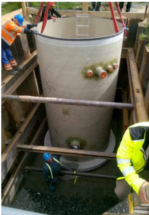
▲ Hrdlořezy, montáž nové ČS odpadních vod
