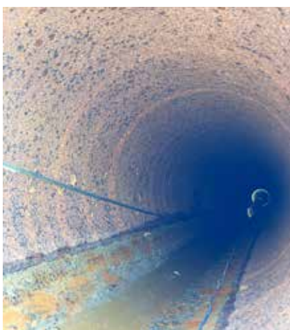
▲ Čištění vod. řadu DN 600 mm před cementací
