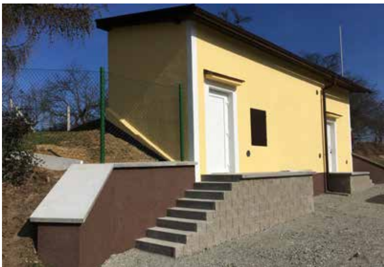
▲ Koryta, oprava vodojemu a čerpací stanice
