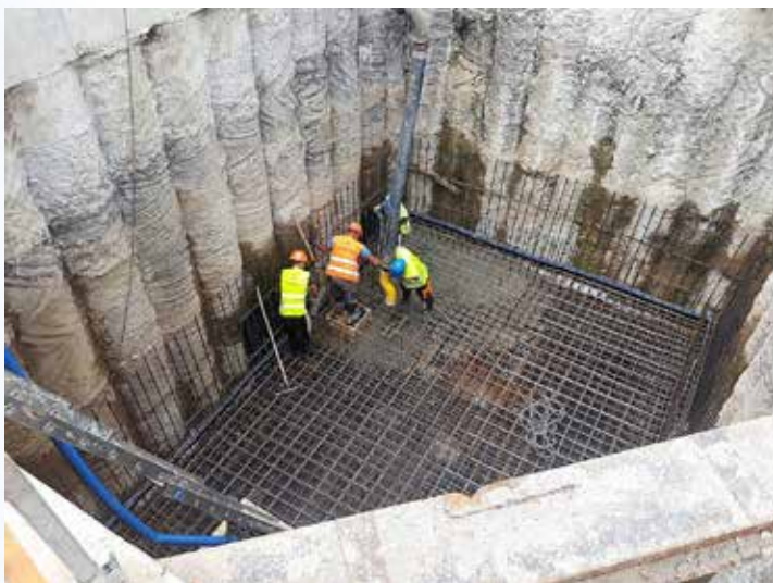
▲ Brodce, zajištění stav. jámy pro novou ČS odpadních vod
