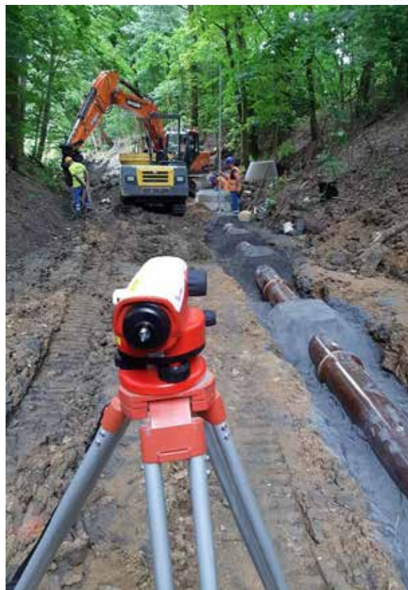
▲ Mladá Boleslav - Podchlumí, výstavba kanalizace
