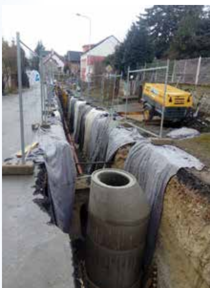
▲ Malá Bělá, výstavba kanalizace
