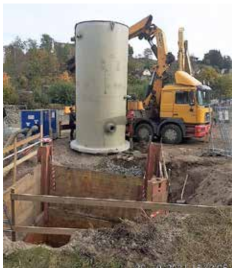
▲ Písková Lhota, montáž nové ČS odp. vod
