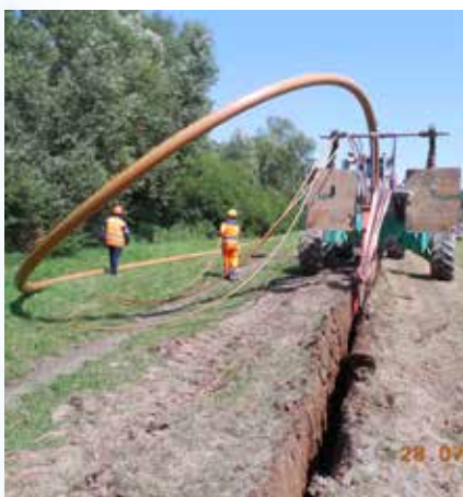
▲ Pluhování kanal. přivaděče JIH
