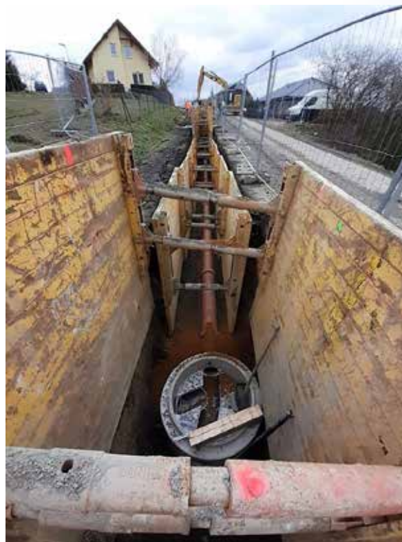
▲ Úherce, výstavba kanalizace
