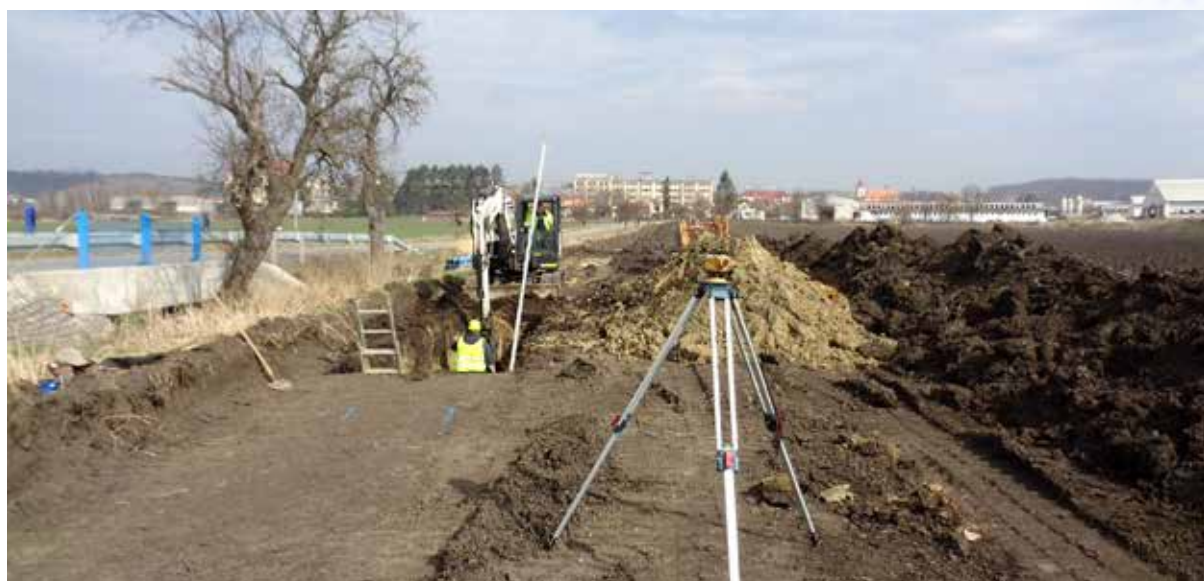
▲ Pěčice, vodovodní přivaděč
