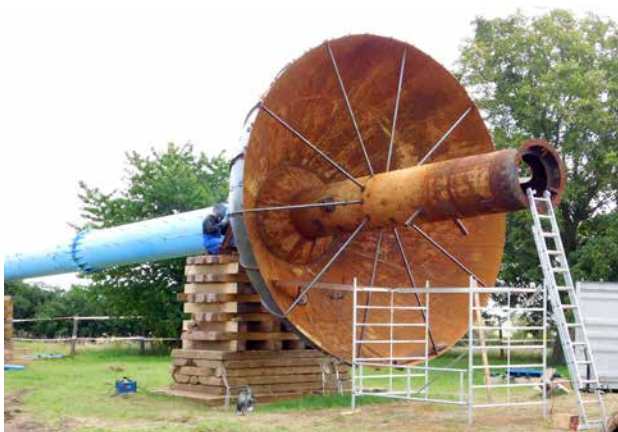
▲ Bukovno, oprava vodojemu
