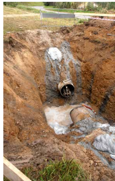
▲ Cementace řadu H prohlídka kamerou po cementaci
