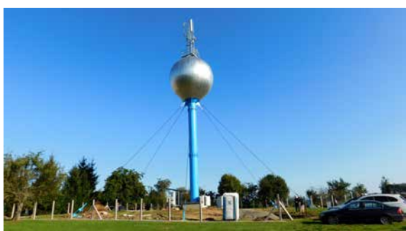
▲ Loukovec, oprava věžového vodojemu 200 m 3
