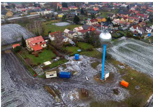
▲ Bukovno, oprava vodojemu
