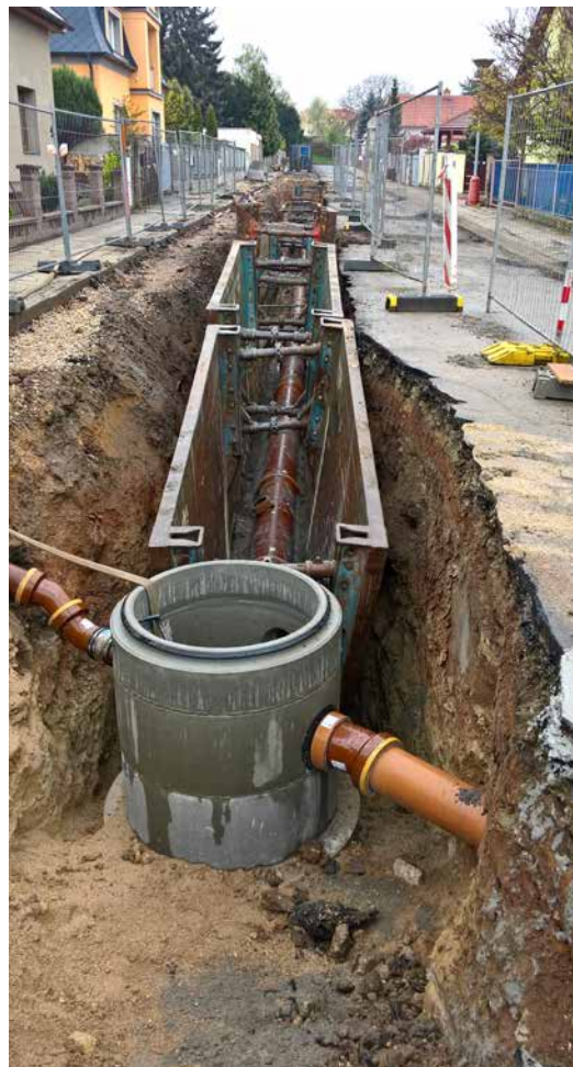
▲ Benátky, ul. V Zahrádkách, obnova kanalizace
