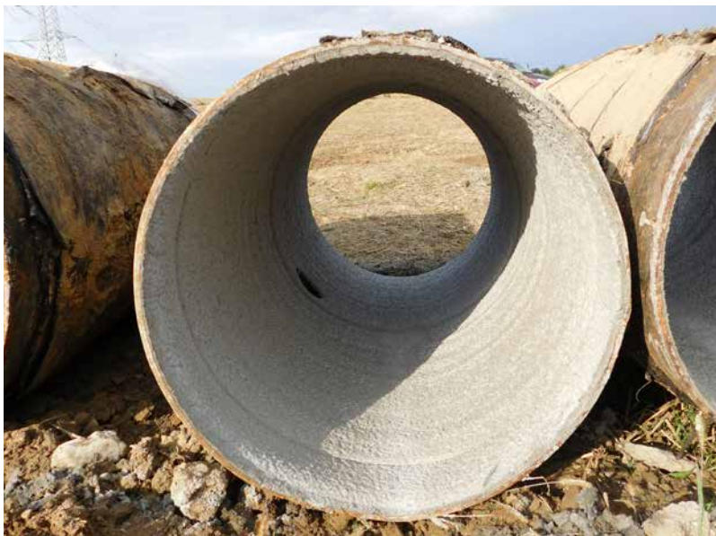
▲ Cementace řadu H, ukázka provedené cementové výstelky
