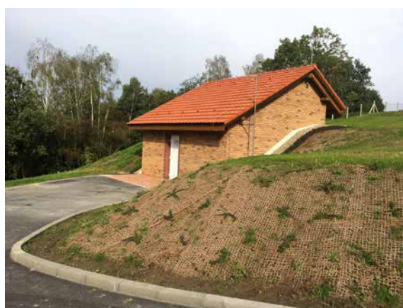
▲ Kněžmost, nový zemní vodojem 2 x 500 m 3
