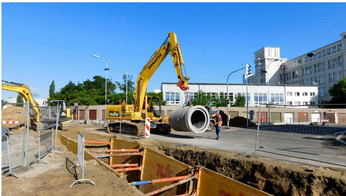
▲ Ml. Boleslav, ul. Dukelská - pokládka kanalizace
