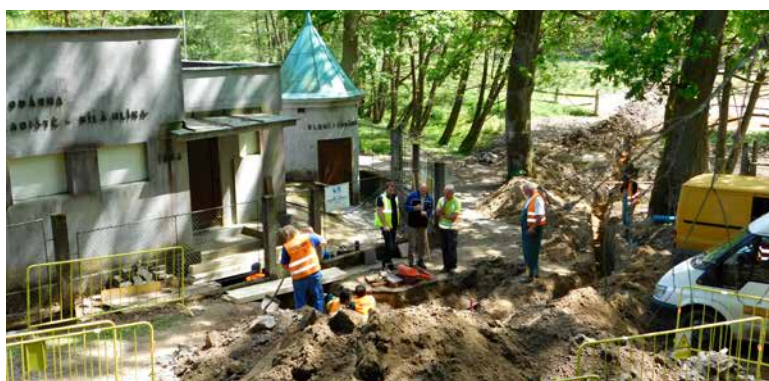
▲ ► Klášter Hradiště, obnova výtlačného řadu LT 150 mm
