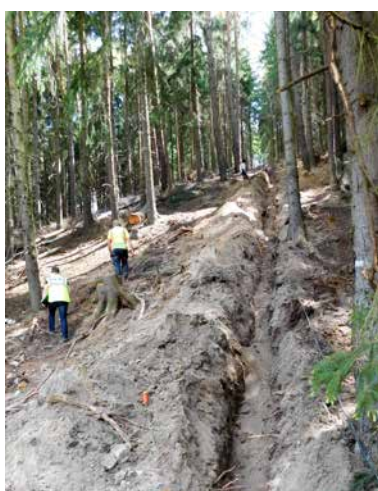
▲ ► Klášter Hradiště, obnova výtlačného řadu LT 150 mm
