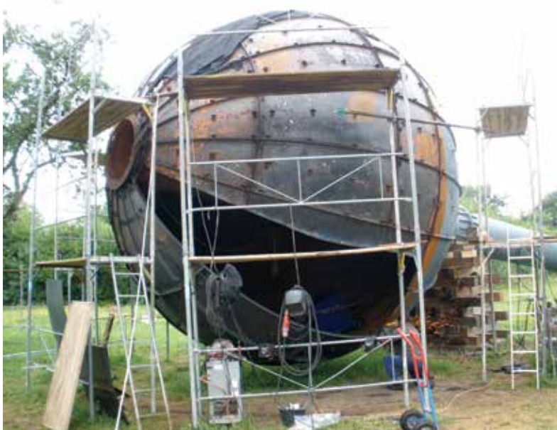
▲ ▶ Oprava ocelových věžových vodojemů (vodojem Zdětín)
