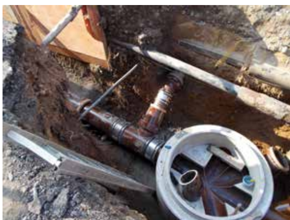
▲ Bakov nad Jizerou, Tržní ulice, oprava kanalizace
