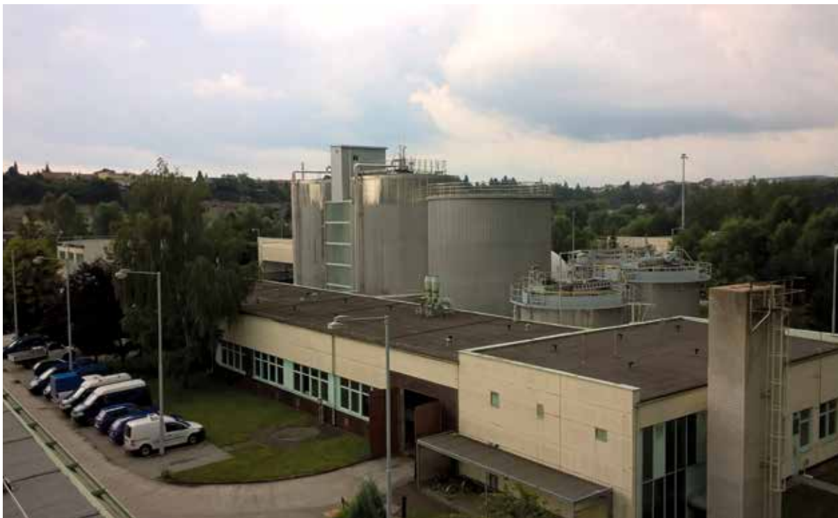
▲ Mladá Boleslav, ČOV II , rekonstrukce vyhnívacích nádrží
