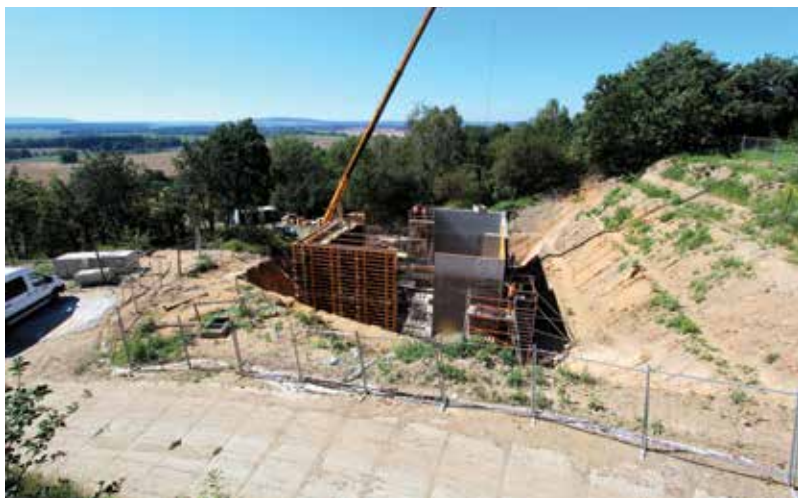
▲ Nový vodojem Kněžmost, bednění a betonáž akumulční nádrže
