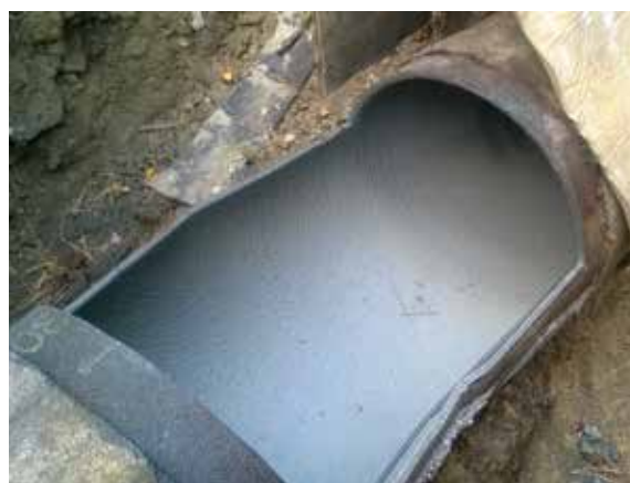
▲ Cementace ocel. řadu DN 500 mm do vodojemu Jiříce
