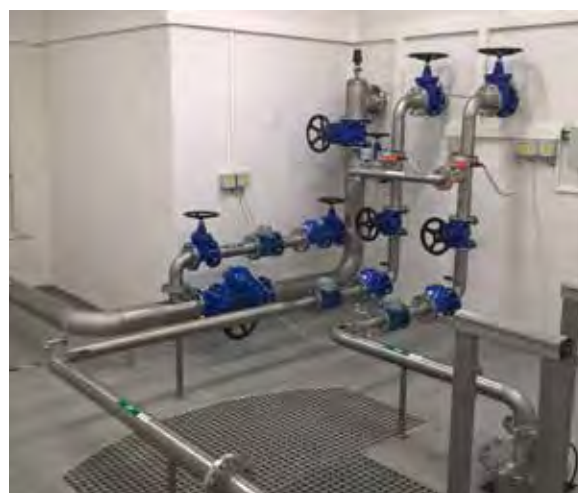
▲ Čerpací stanice Benátky nad Jizerou, po rekonstrukci - technologie
