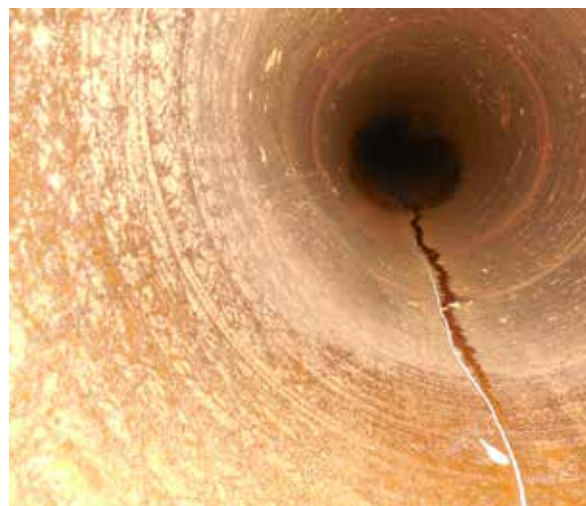
▲ Cementace řadu H - očištěné potrubí
