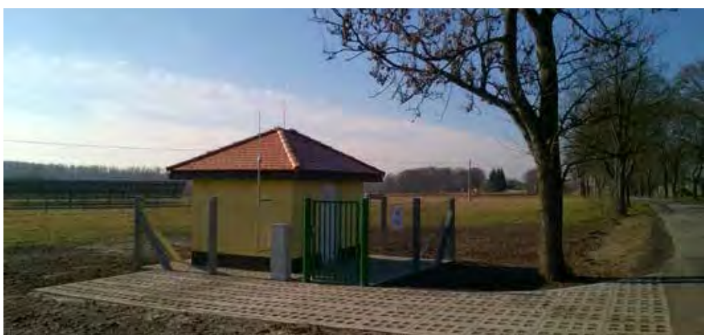
▲ Řešení kvality pitné vody na Kněžmostsku - PČS Koprník, interiér a celkový pohled
