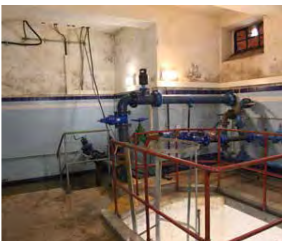
▲ Čerpací stanice Benátky nad Jizerou, před rekonstrukcí
