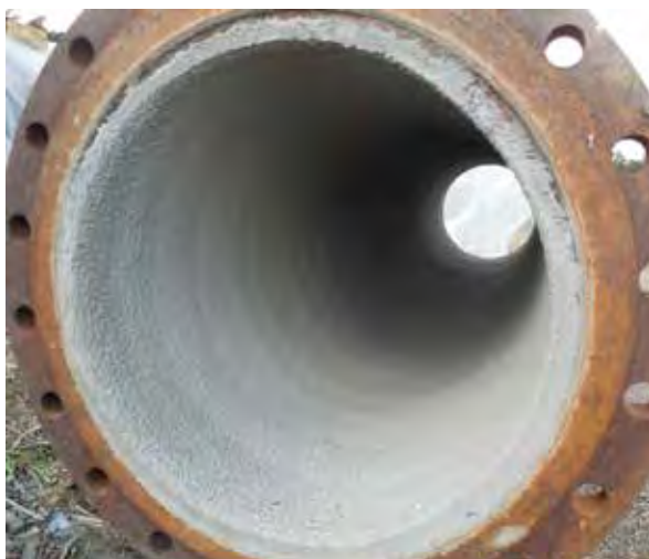
▲ Cementace řadu H - výsledný povrch potrubí
