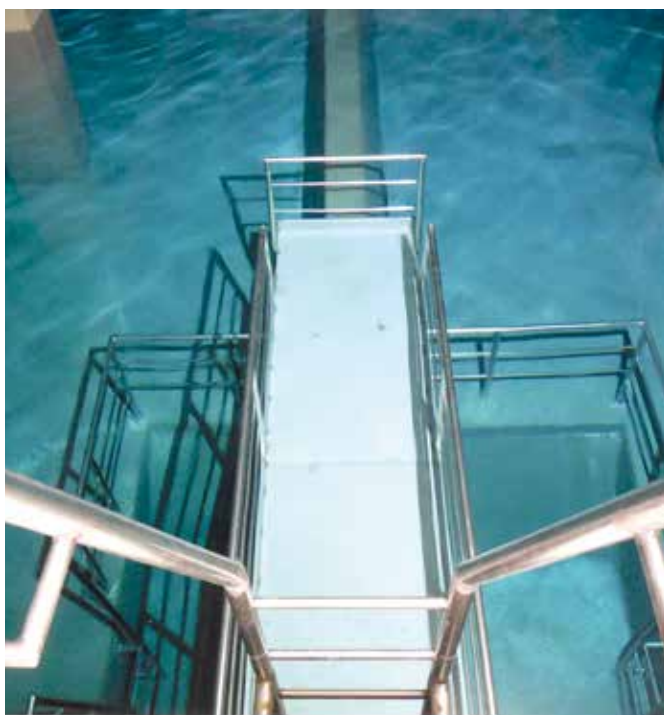
▲ Vodojem Dobrovice, pohled do vodní komory
