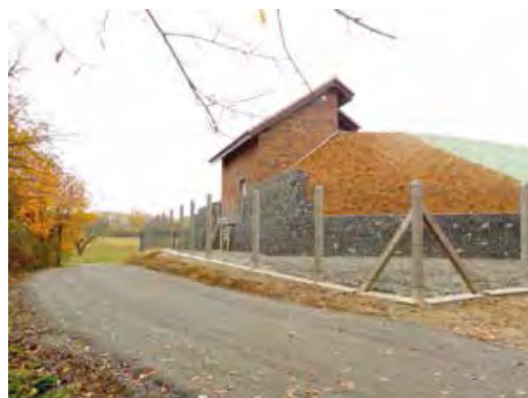
▲ Vodojem Horní Stakory po rekonstrukci
