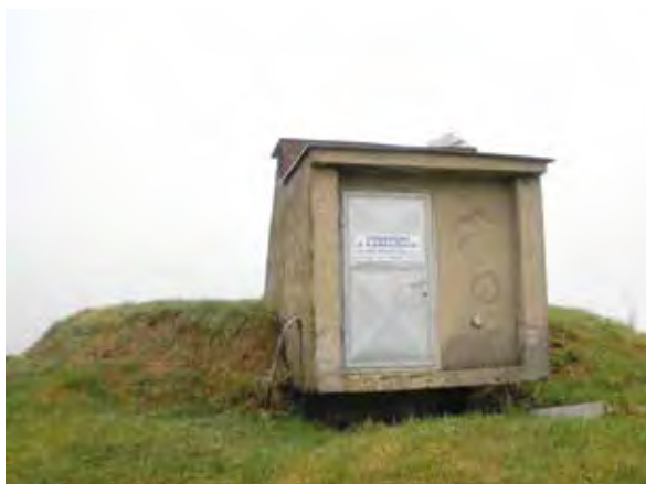
▲ Vodojem Holé vrchy před rekonstrukcí
