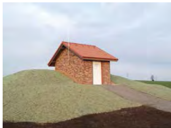
▲ Vodojem Holé Vrchy po rekonstrukci
