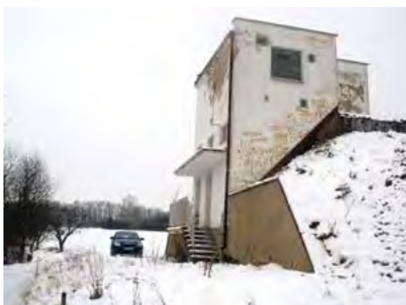
▲ Vodojem Horní Stakory před rekonstrukcí
