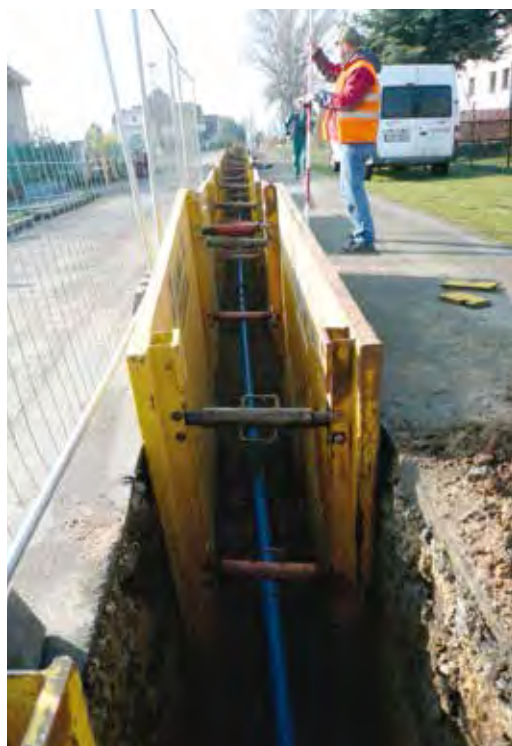
▲ Bezno, ul. Jana Švermy, výkopová rýha pro vodovod
