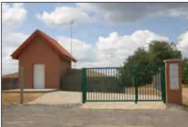
▲ VDJ Březovice po rekonstrukci
