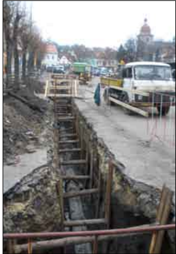
▲ Dobruvice, náměstí obnova vod. řadů
