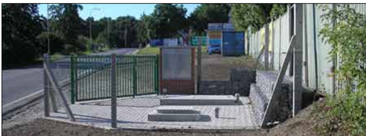
▲ Kosmonosy, čerpací stanice odpadních vod
