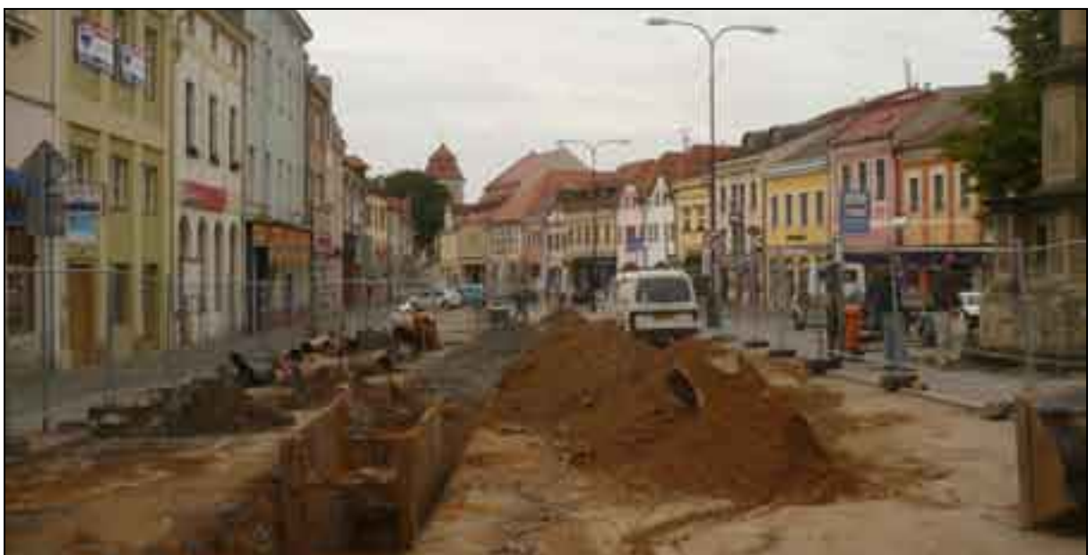
▼ Mladá Boleslav, Staroměstské nám. rekonstrukce kanalizace
