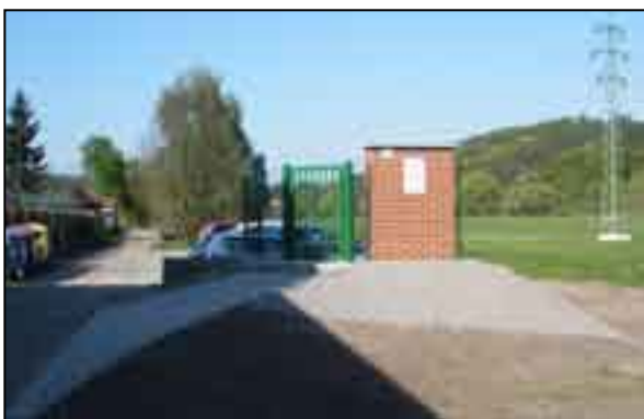
▲ Debř, čerpací stanice odpadních vod Pod školou
