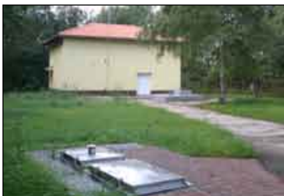
▲ ČS Sychrov, připojení nového zdroje
