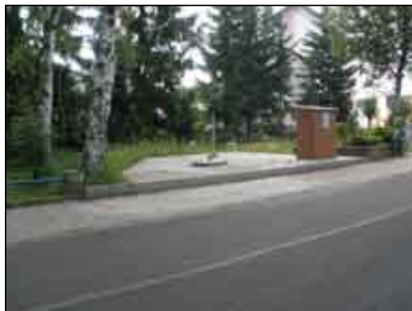
▲ Benátky n. Jizerou, čerpací stanice odpadních vod
