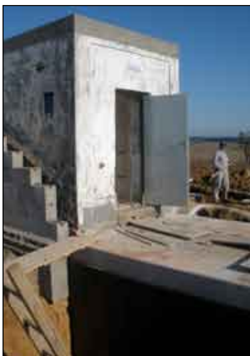
▲ VDJ Březovice před rekonstrukcí
