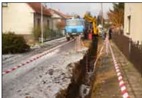
▲ Dalovice, obnova vodovodních řadů
