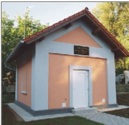
Rekonstrukce vodojemu v obci Sedlec
