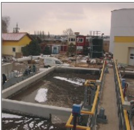
Rekonstrukce ČOV Benátky nad Jizerou
