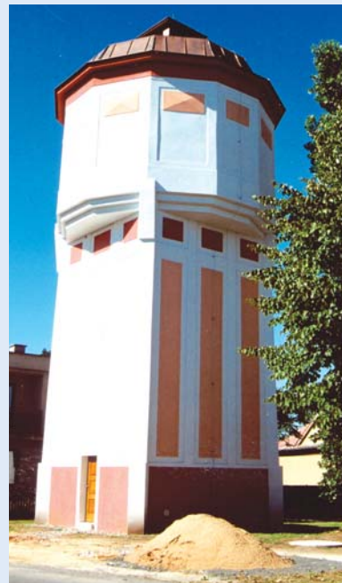
Věžový vodojem Mečeříž
