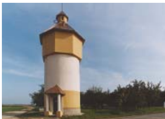
Zrekonstruovaný vodojem Sedlisko
