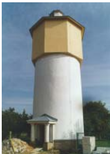
Opravený vodojem Rostkov
