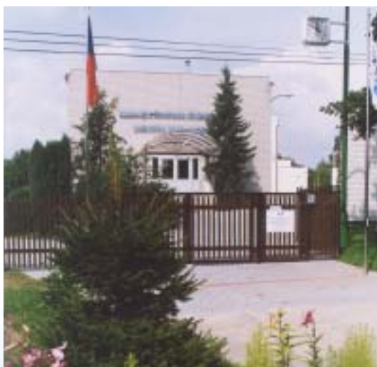
Úpravna vody Rečkov
