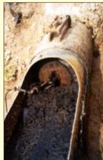
Skupinový vodovod Mladá Boleslav - cementace hlavního výtlačného řadu "A" - DN 600 - z úpravny vody Rečkov do Mladé Boleslavi
