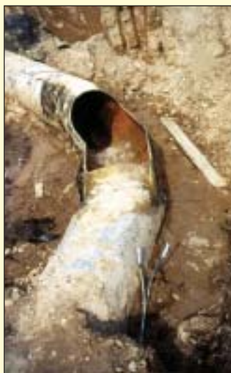
Skupinový vodovod Mladá Boleslav - cementace hlavního výtlačného řadu "A" - DN 600 - z úpravny vody Rečkov do Mladé Boleslavi
