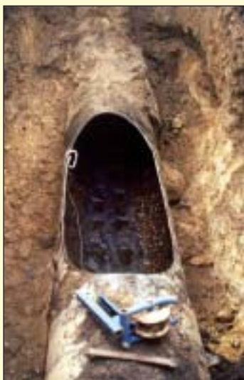
Skupinový vodovod Mladá Boleslav - cementace hlavního výtlačného řadu "A" - DN 600 - z úpravny vody Rečkov do Mladé Boleslavi
