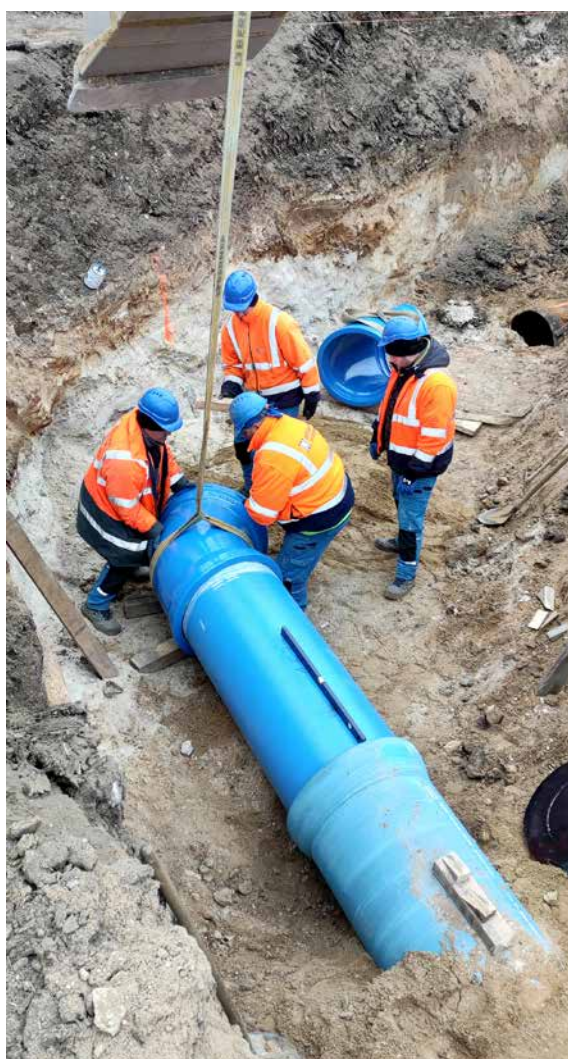
▲ Kosmonosy, obnova části přívodního řadu LT 600
