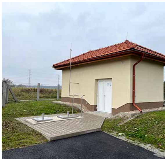
▲ Sobětuchy, nový vrt a vodojem
