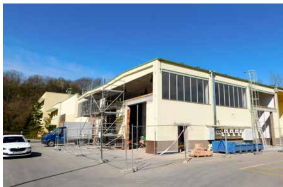
▲ ČOV II, rekonstrukce zázemí autodopravy
