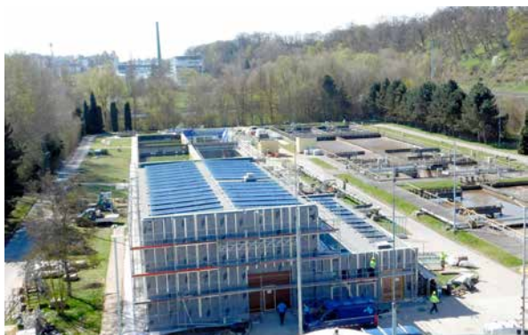
▲ ČOV II, rekonstrukce
