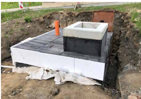
▲ Kosmonosy, obnova části přívodního řadu LT 600
