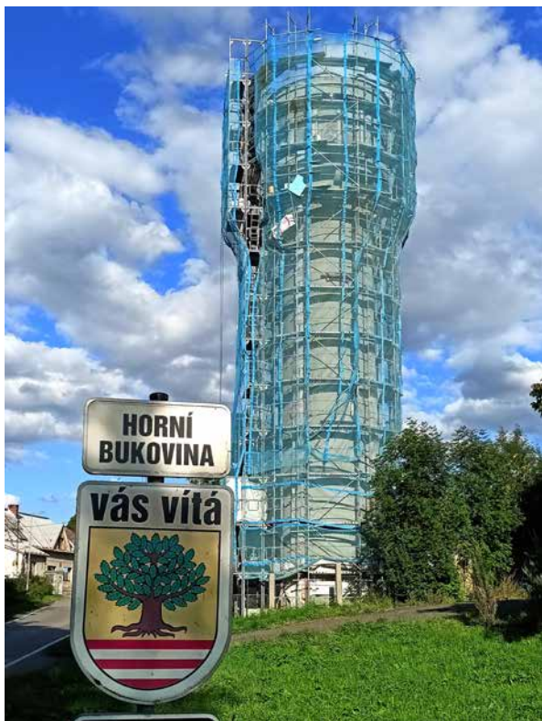
▲ Horní Bukovina, oprava vodojemu
