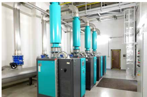
▲ ČOV II, rekonstrukce dmychárny
