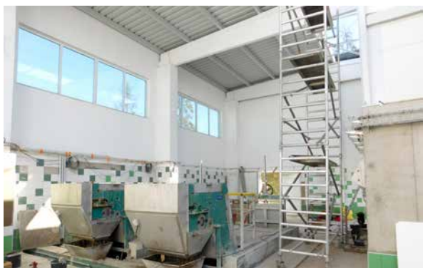
▲ ČOV II, rekonstrukce
