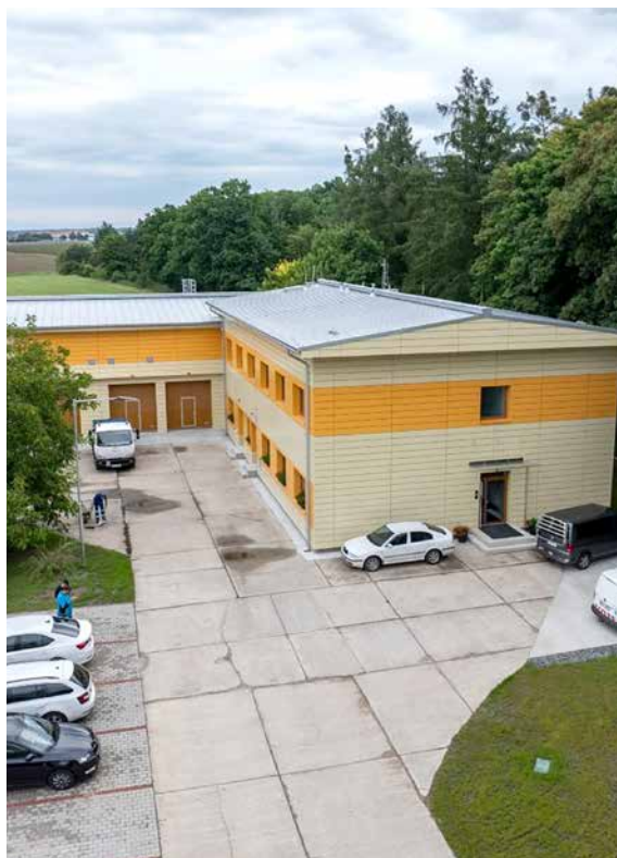
▲ Provozní středisko Benátky n.J., rekonstrukce
