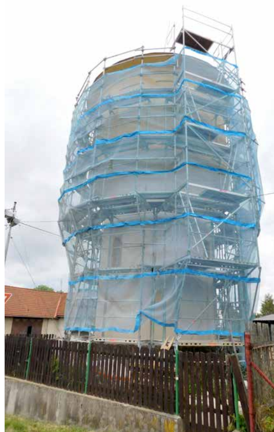
▲ Velké Všelisy, oprava vodojemu
