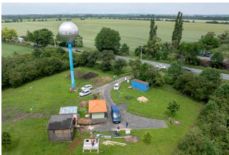
▲ Jizerní Vtelno, nová úprava vody
