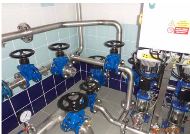
▲ Hrdlořezy, oprava vodojemu
