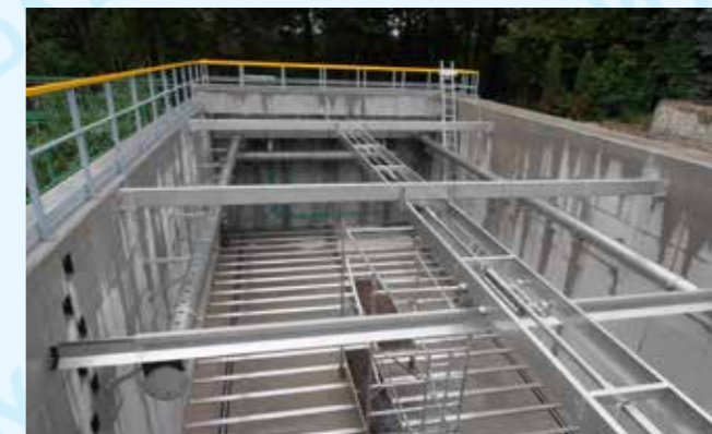
Mníchovo Hradiště ČOV - dosazovací nádrž po rekonstrukci před uvedením do provozu
