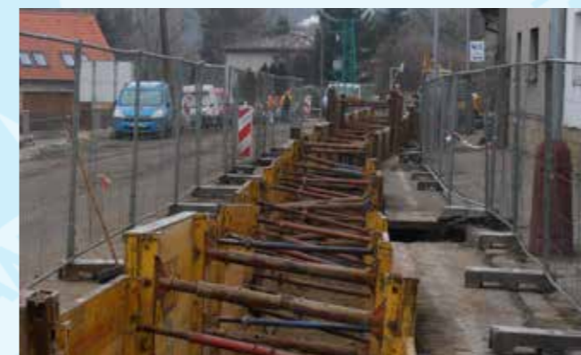
Vinecká ul. - pokládka kanalizační stoky
