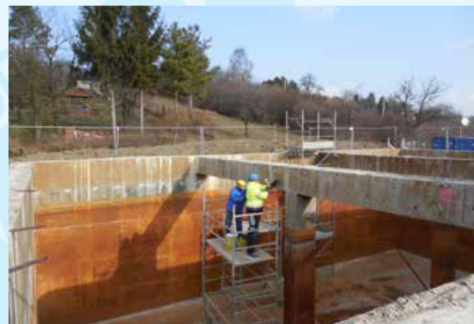
Dobrovice - vodojem, provádění diagnostiky stavu konstrukce
