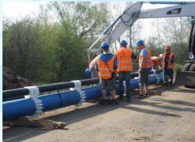
Dobrovice - vodovodní potrubí před zasunutím do chráničky
