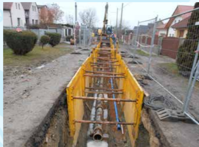
Chrást - pokládka kanalizace a vodovodu v obci
