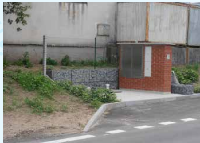
Bezděčín - čerpací stanice odpadních vod
