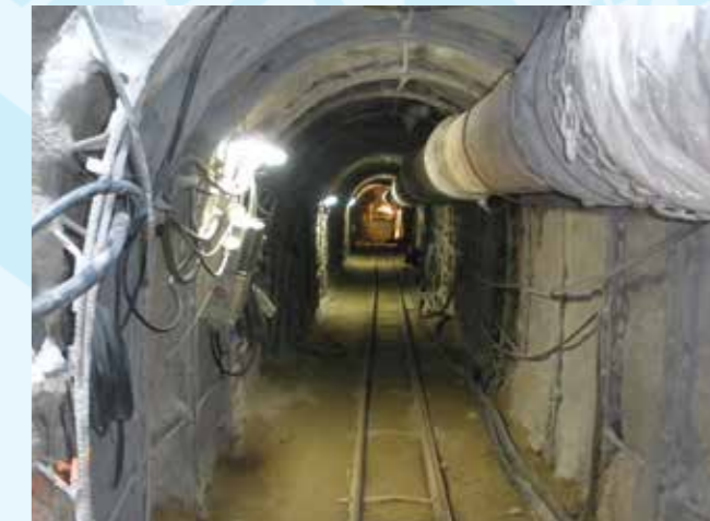
Mníchovo Hradiště, štola - primární ostění po ražbě
