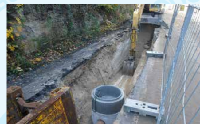
Vinecká ul. - rozpojování skalního podloží stoky
