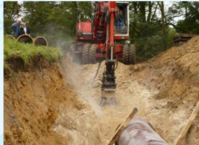
Bakov, rozpojování skály skalní frézou
