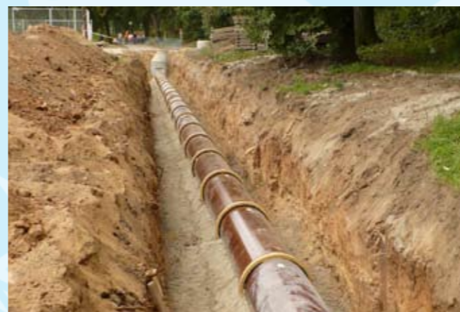
Bakov - Rybní Důl, pokládka hlavní stoky DN 600 mm
