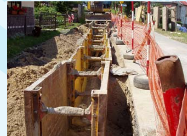
Bělá - Papírenská ulice, výstavba kanalizace
