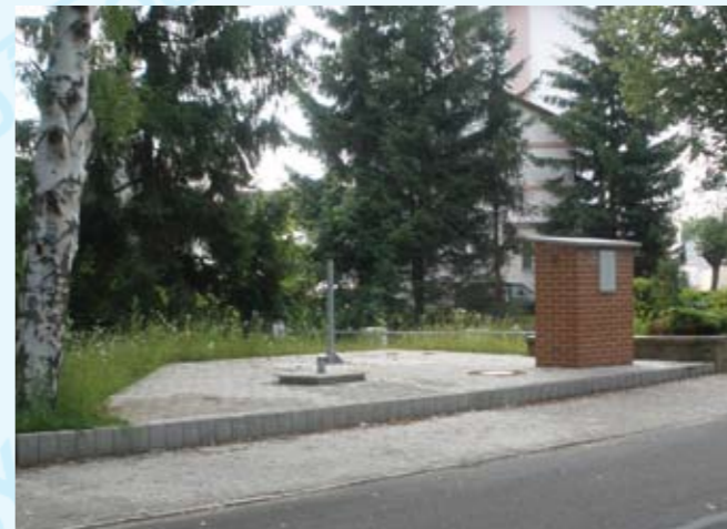
Benátky, čerpací stanice odpadních vod
