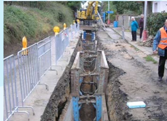
Benátky, pokládka kanalizace
