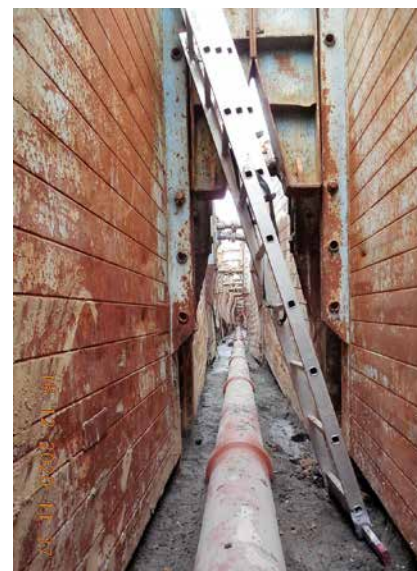
▲ Kolomuty, výstavba kanalizace
