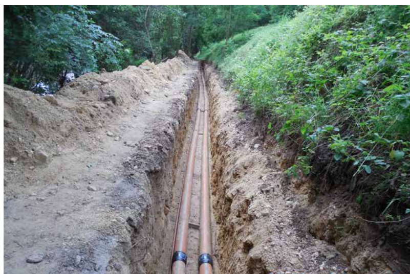
▲ Výstavba kanalizačního přivaděče JIH
