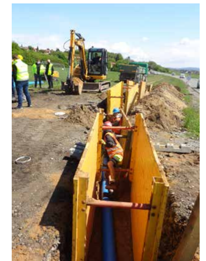
▲ Kosmonosy-západ, výstavba vodovodu
