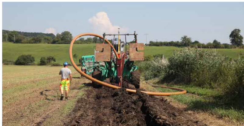
▲ Horní Stakory, výstavba kanalizačního přivaděče metodou pluhování
