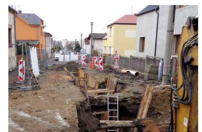
▲ Kosmonosy, Podzámecká ul. - obnova vodovodu a kanalizace
