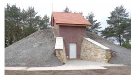
▲ Dolní Slivno, rekonstrukce vodojemu
