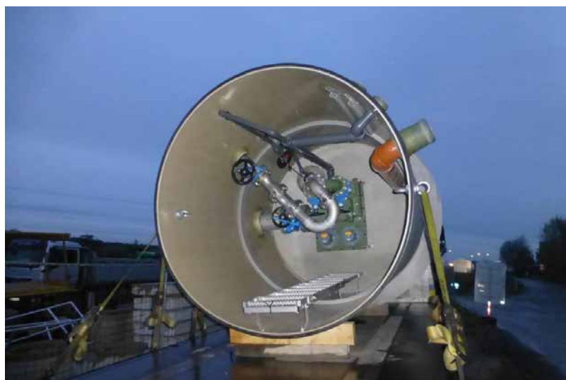
▲ Hrdlořezy, výstavba kanalizace
