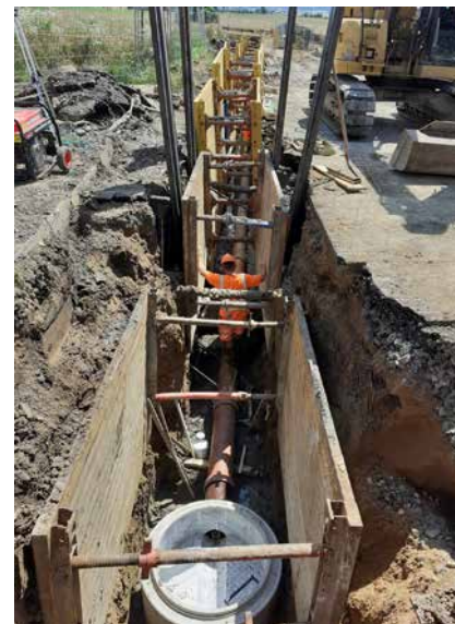
▲ Horní Stakory, výstavba kanalizace
