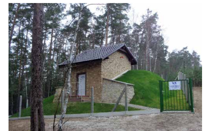
▲ Srbsko, rekonstrukce vodojemu
