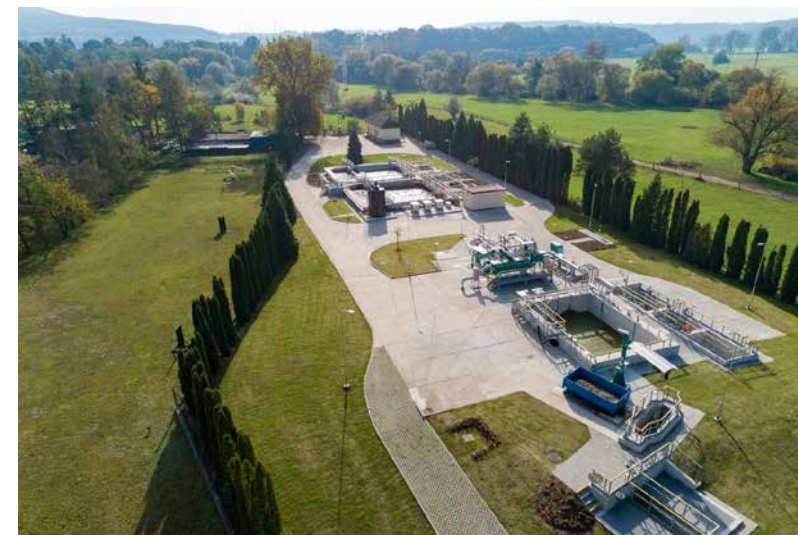
▲ ČOV Bakov nad Jizerou po rekonstrukci
