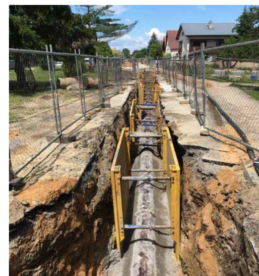
▲ Luštěnice, Školní ul. - rekonstrukce kanalizace
