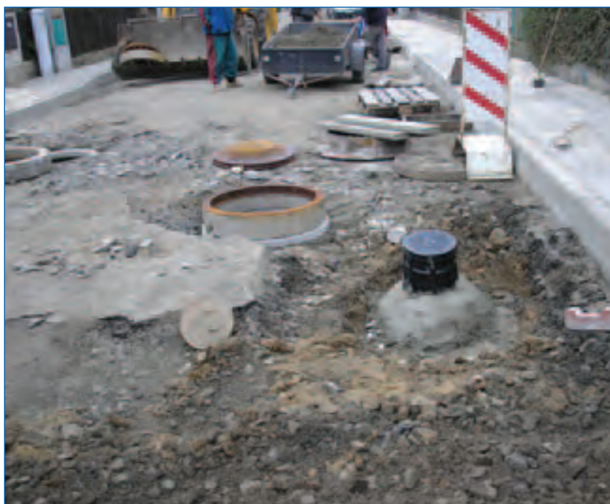
Oprava kanalizační šachty - Benátky nad Jizerou, Soukalova ul.
