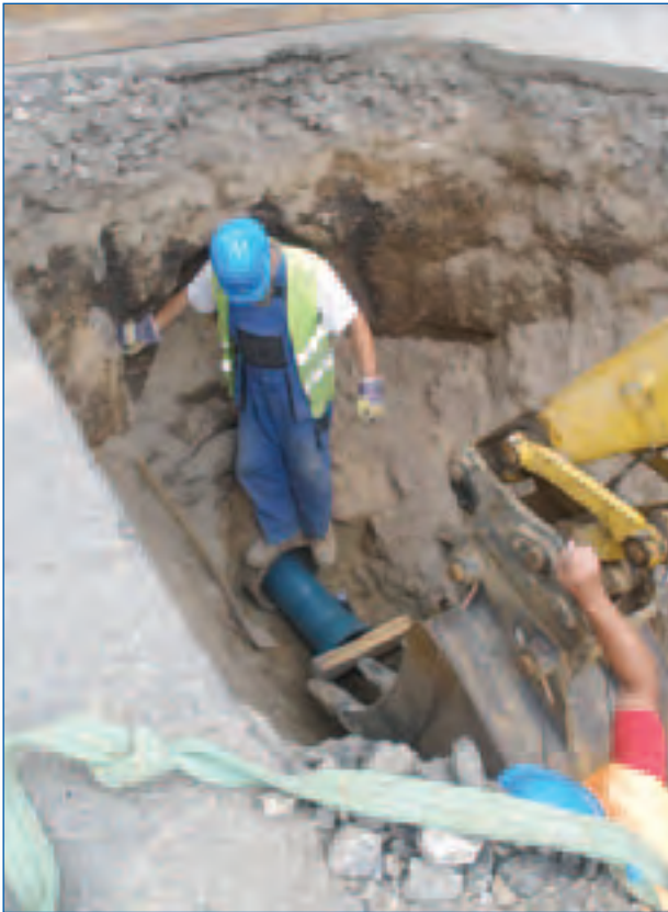
Příprava trub do chráničky Benátky nad Jizerou, ul. 5. května
