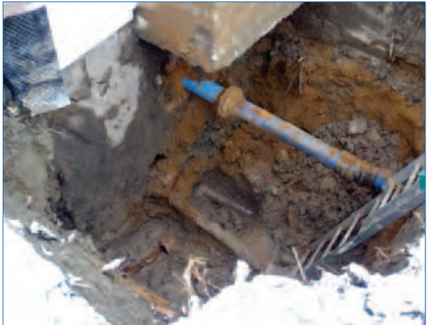
Výkop odpadu z VDJ Dobrovice
