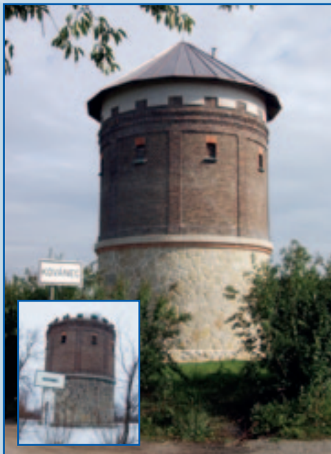
Kováncovský - věžový vodojem
