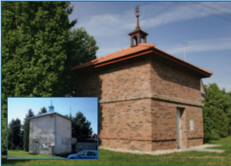
Pětikožly - zemní vodojem
