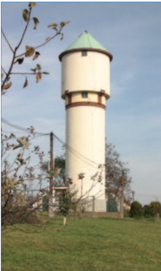
Bílá Hlína - věžový vodojem
