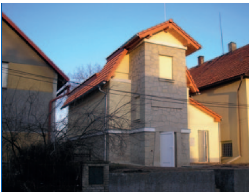
Skalsko - nadzemní vodojem
