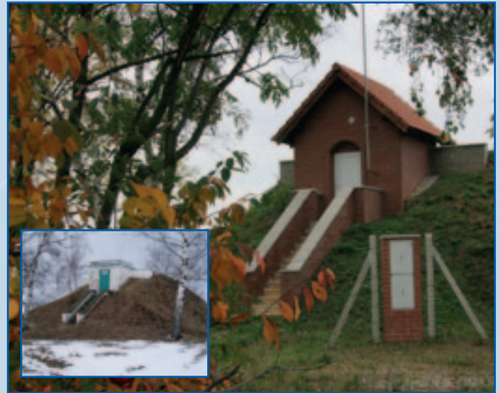
Čistá - zemní vodojem
