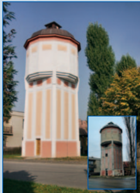
Měčeříž - věžový vodojem
