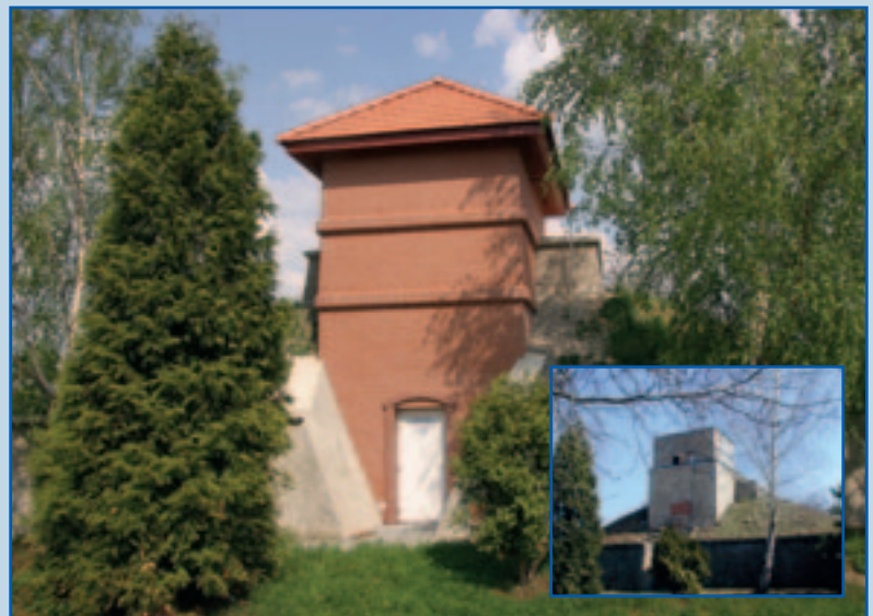
Sedlec - zemní vodojem
