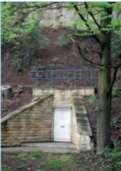
▲► Mnichovo Hradiště, lokalita Nedbalka – podzemní objekt výtláčeňého potrubí odpadních vod
