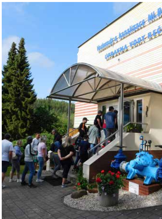
Rečkov – úpravna vody
