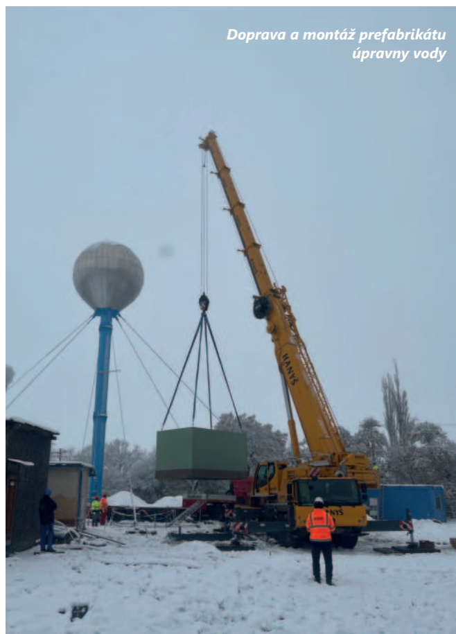
Nový objekt úpravný vody
