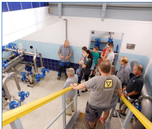
Dobrovice, vodojem – interiér
