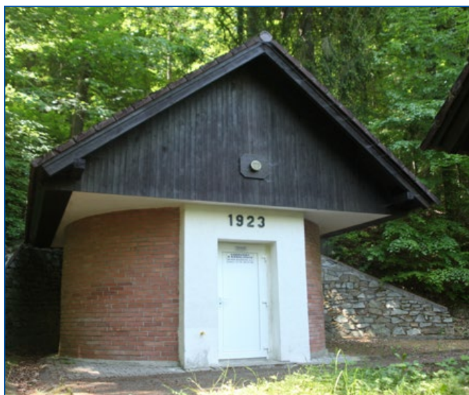
Buřínsko, čerpací stanice
