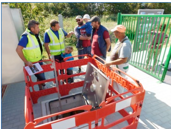
Žerčice, čerpací stanice
