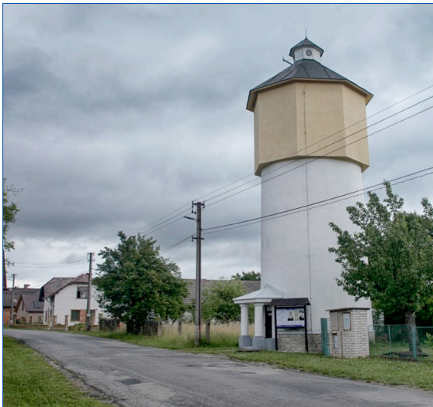
Rostkov, věžový vodojem
