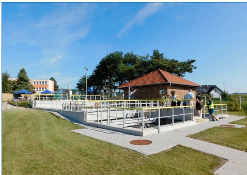
Semčice, čistírna odpadních vod
