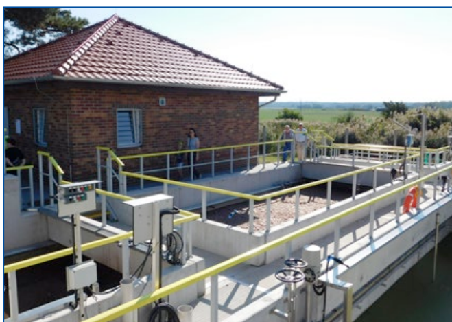
Semčice, čistírna odpadních vod
