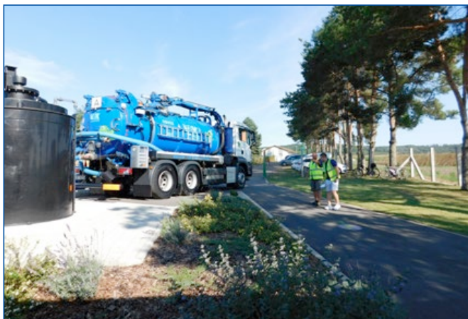
Semčice, čistírna odpadních vod
