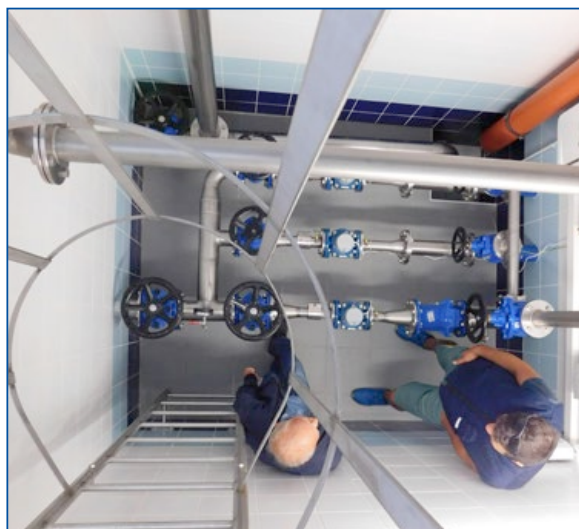
Holé Vrchy, vodojem – interiér
