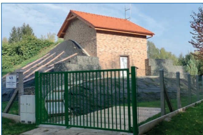
Žerčice – rekonstrukce zemního vodojemu nákladem 4,32 mil. Kč
