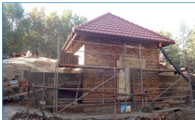
Klášteř Hradiště – rekonstrukce zemního vodojemu nákladem 4,67 mil. Kč
