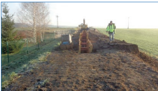
Žerčice – výstavba kanalizačního výtlaku a ČSOV ve výši 3,41 mil. Kč
