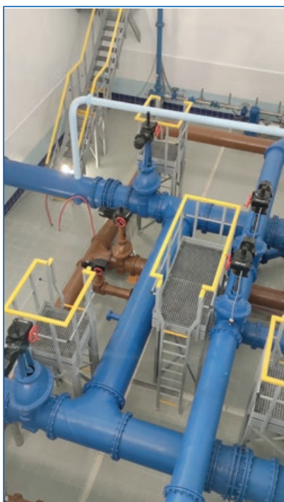
Bradlec – oprava armaturní komory a sanace železo-betonových konstrukcí vodojemu ve výši 6,59 mil. Kč
