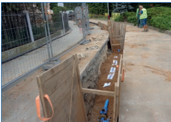
Mladá Boleslav, Alešova ulice – oprava vodovodu nákladem 7,22 mil. Kč
