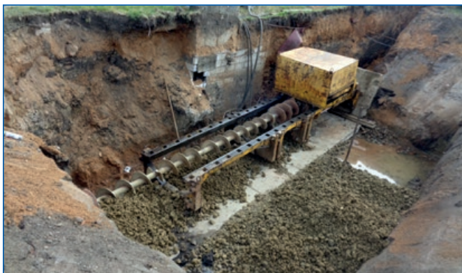
Plazy – obnova vodovodu (protlak) nákladem 4,12 mil. Kč
