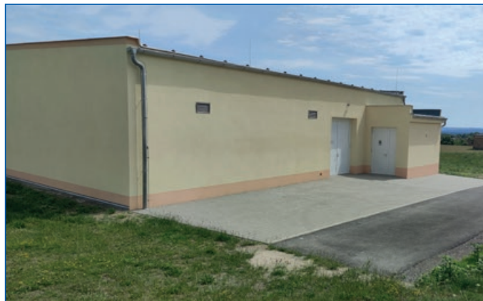
Bradlec – oprava fasády vodojemu 2 x 3 000 m 3 nákladem 0,46 mil. Kč
