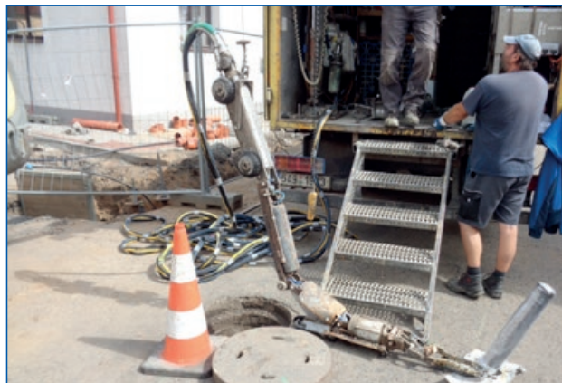
Bezvýkopové opravy kanalizace nákladem 2,06 mil. Kč
