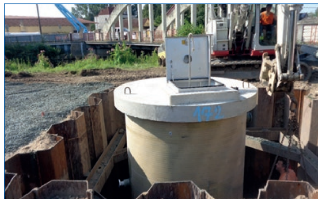
Horky nad Jizerou – výstavba kanalizačního výtlaku a ČSOV ve výši 5,17 mil. Kč
