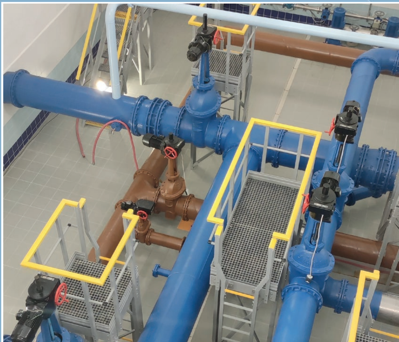
Bradlec, vodojem – oprava armaturní komory vodojemu
