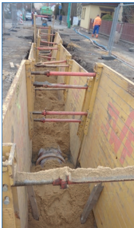
Kosmonosy – 4. a 5. etapa obnovy vodovodů a kanalizací ve výši 22,04 mil. Kč
