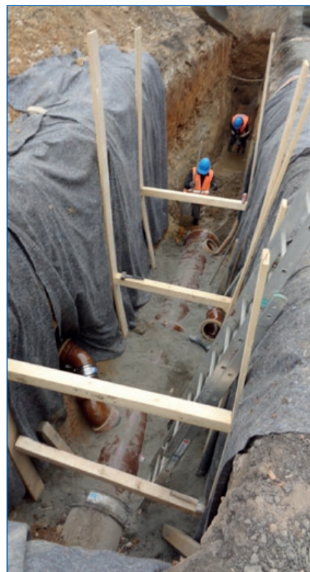
Mnichovo Hradiště, ulice Komenského a Boženy Němcové – obnova vodovodu a kanalizace ve skalním podloží nákladem 6,23 mil. Kč
