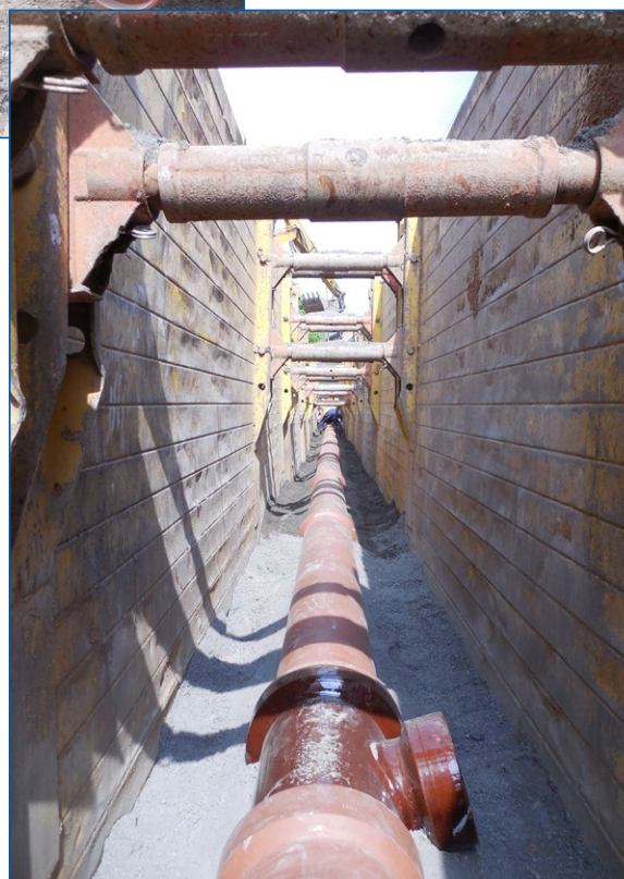
Úherce, montáž kanalizace DN 250 mm, stoka A2
