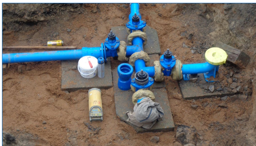
Kosmonosy, Podzámecká ulice – vodovod
