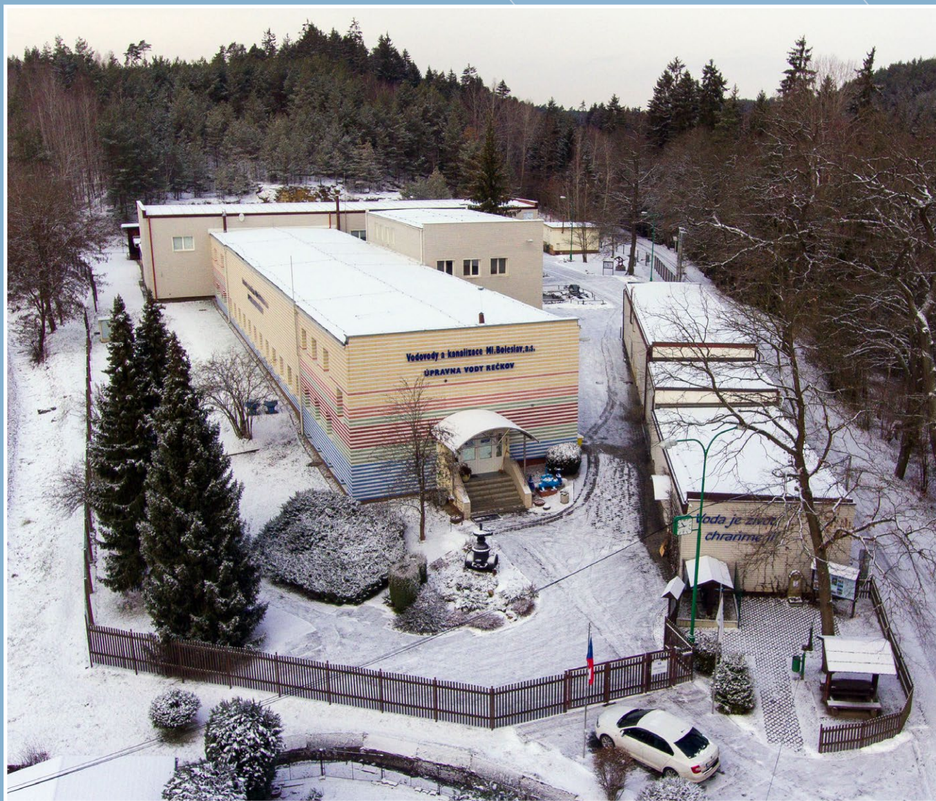
Rečkov – úprava vody
