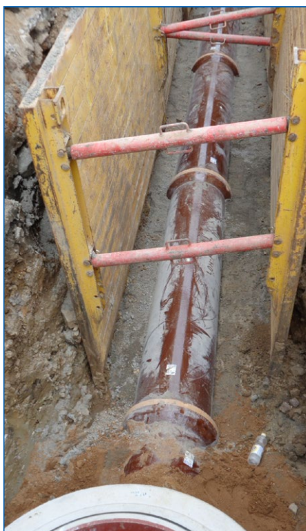
Kosmonosy, Tyršova ulice – kanalizace
