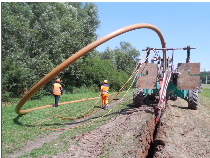
Mladá Boleslav, kanalizační přivaděč JIH – pluhování potrubí d 180 mm
