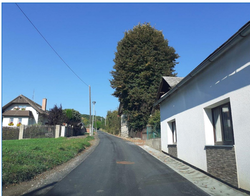
Horní Stakory - oprava místní komunikace po výstavbě kanalizace
