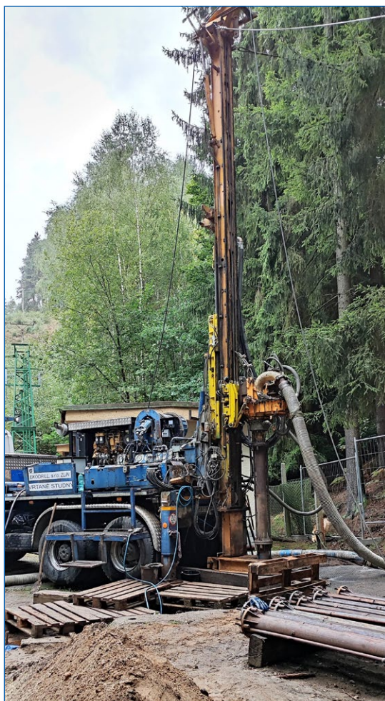
Čerpací a stoupací zkouška na vrtu KL-5A
