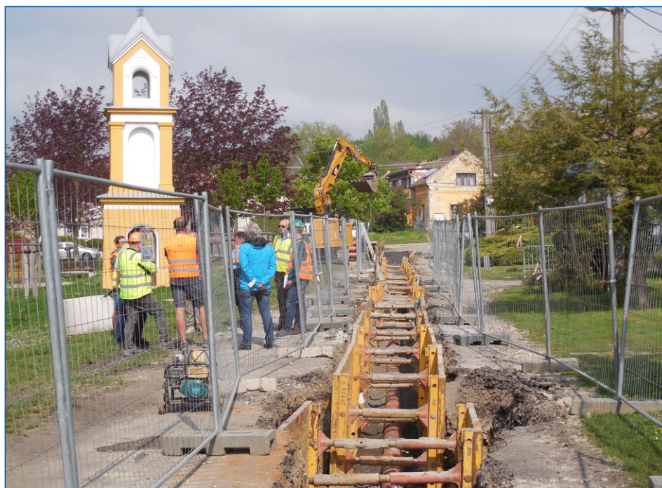
Úherce – výstavba kanalizace, stoka A2
