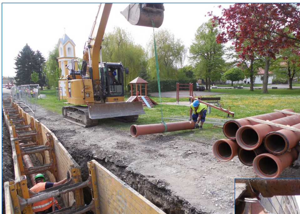
Úherce, montáž kanalizace DN 250 mm, stoka A2
