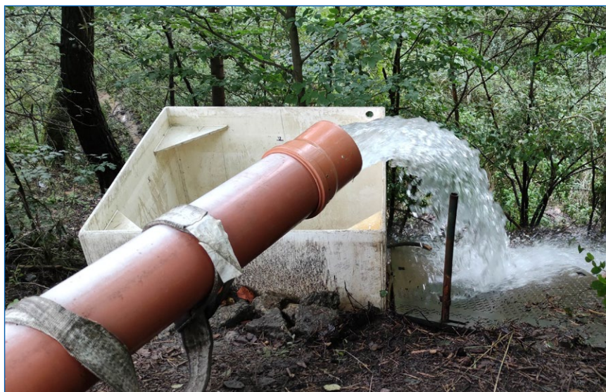
KL-5A, čerpací zkouška 20 l/sec
