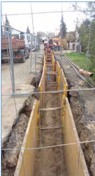
Kosmonosy – obnova vodovodu a kanalizace
