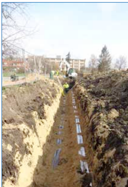
Pěčice – vodovodní a kanalizační přivaděč
