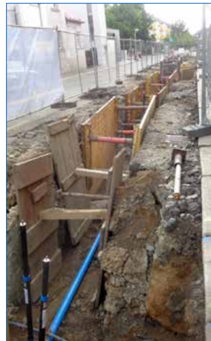
Mladá Boleslav, Bezručova ulice – oprava vodovodu
