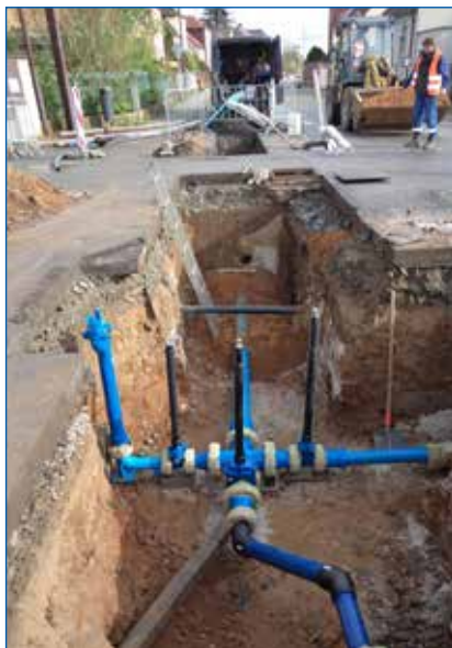
Benátky nad Jizerou, ulice Boženy Němcové a Boleslavská – oprava vodovodu
