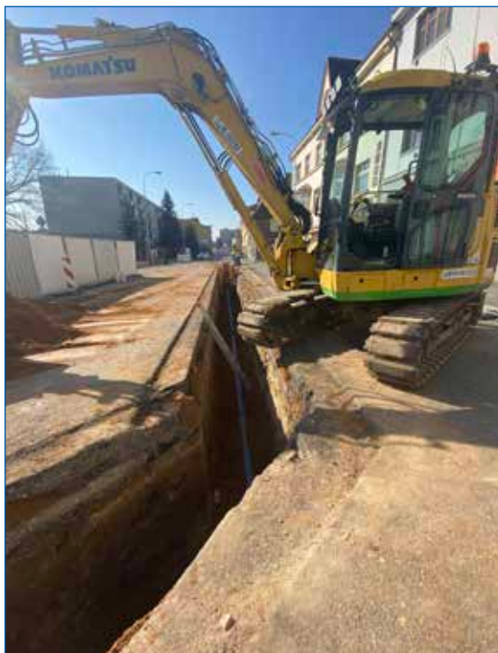
Mnichovo Hradiště, ulice Víta Nejedlého – obnova vodovodu
