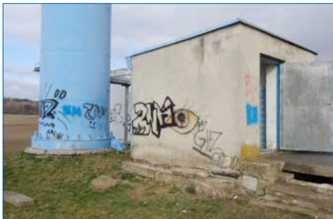
Čachovice, vodojem – původní a nový stav
