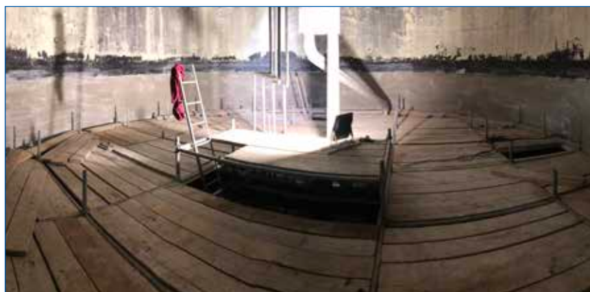
Mladá Boleslav, Podlázky ČOV II – sanace vyhnivací nádrže
