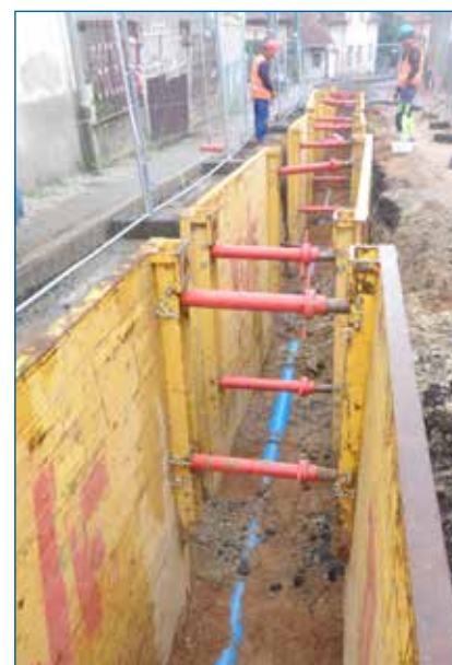
Horky nad Jizerou – obnova vodovodu
