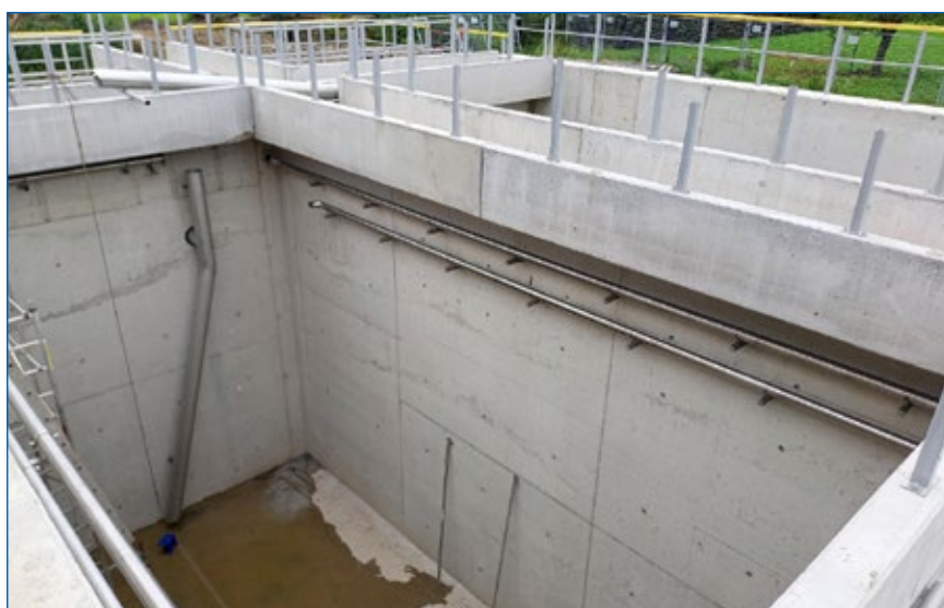
Semčice – intenzifikace ČOV, montáž technologického vstrojení
