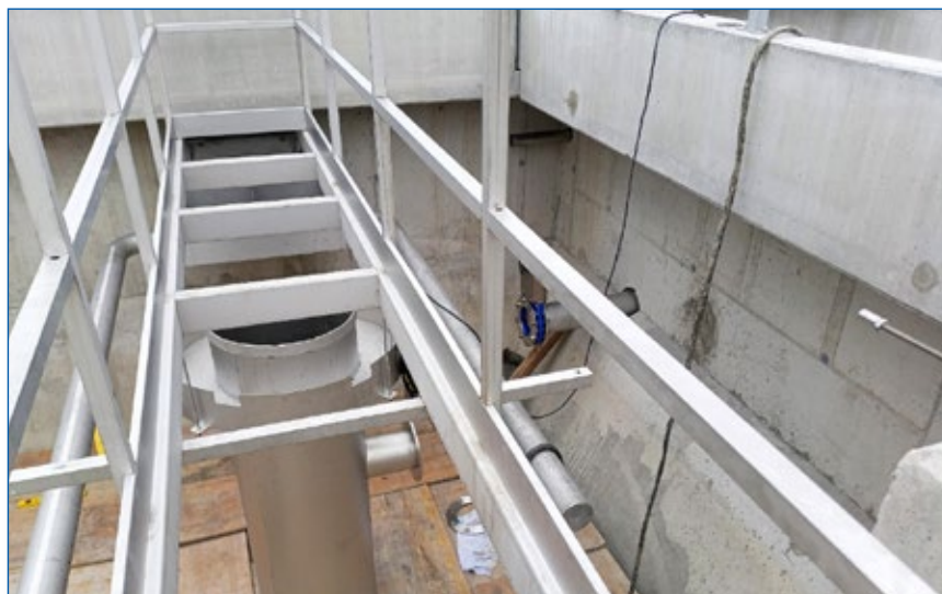
Semčice intenzifikace ČOV – montáž technologického vstrojení
