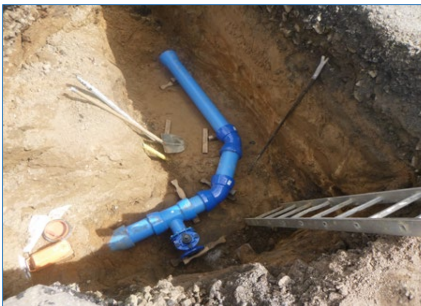
Bakov nad Jizerou, ulice Boženy Němcové a Boleslavská – oprava vodovodu
