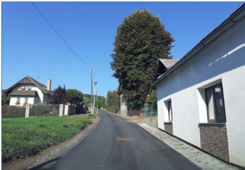
Horní Stakory – oprava místní komunikace po výstavbě kanalizace
