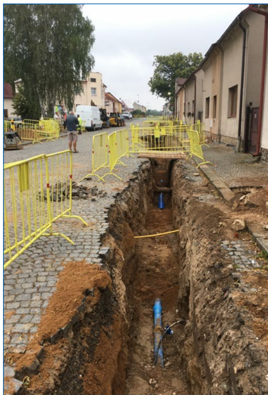
Bakov nad Jizerou, Žižkova ulice – obnova vodovodu před rekonstrukcí komunikace
