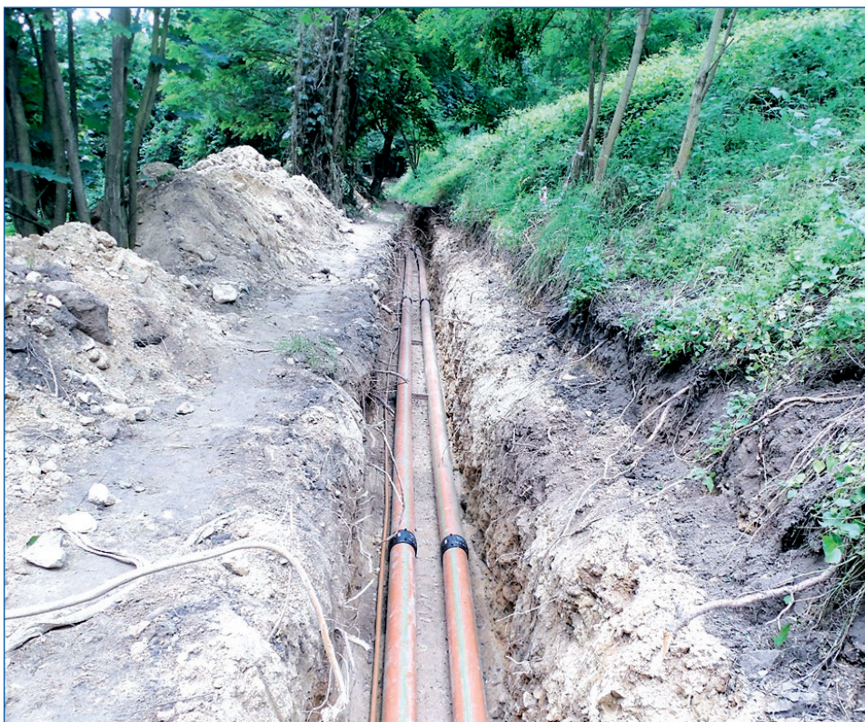
Mezi obcemi Krnsko a Vinec – pokládka zdvojeného výtoku odpadních vod
