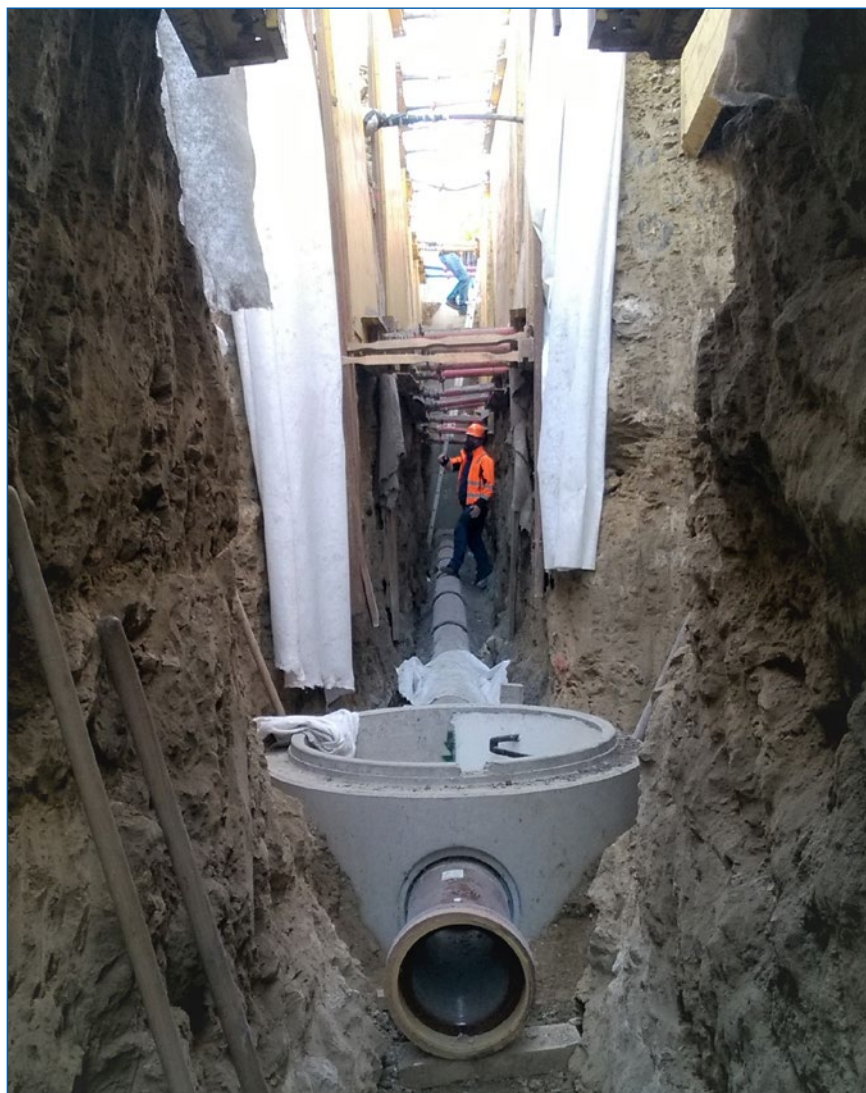
Brodce nad Jizerou, ulice V Úvoze – výstavba kanalizace ve skalním podloží
