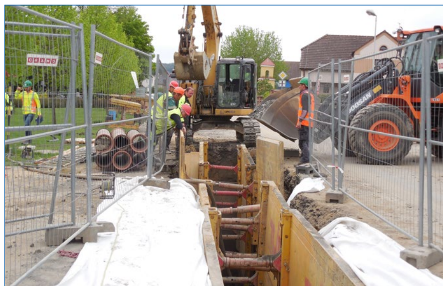
Kolomuty, výstavba kanalizační stoky
