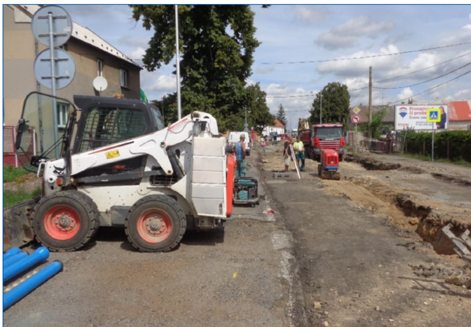
Bezděčín, Pražská ulice – obnova vodovodu před rekonstrukcí komunikace
