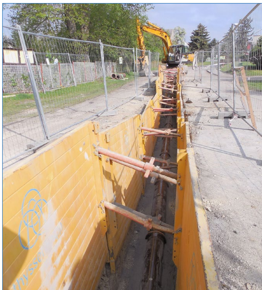
Semčice, výstavba kanalizační stoky 2 S
