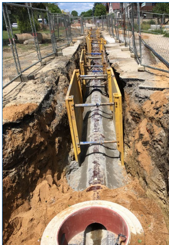
Luštěnice, Školní ulice – oprava kanalizace DN 500 mm
