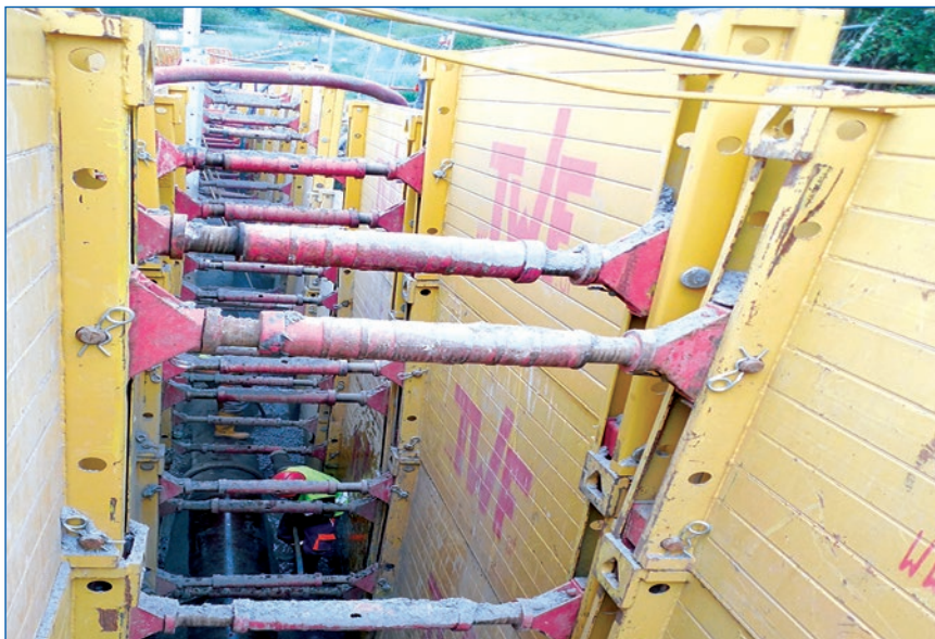
Brodce nad Jizerou, ulice Rudé armády – pokládka potrubí KT 500 mm v hloubce 5 m
