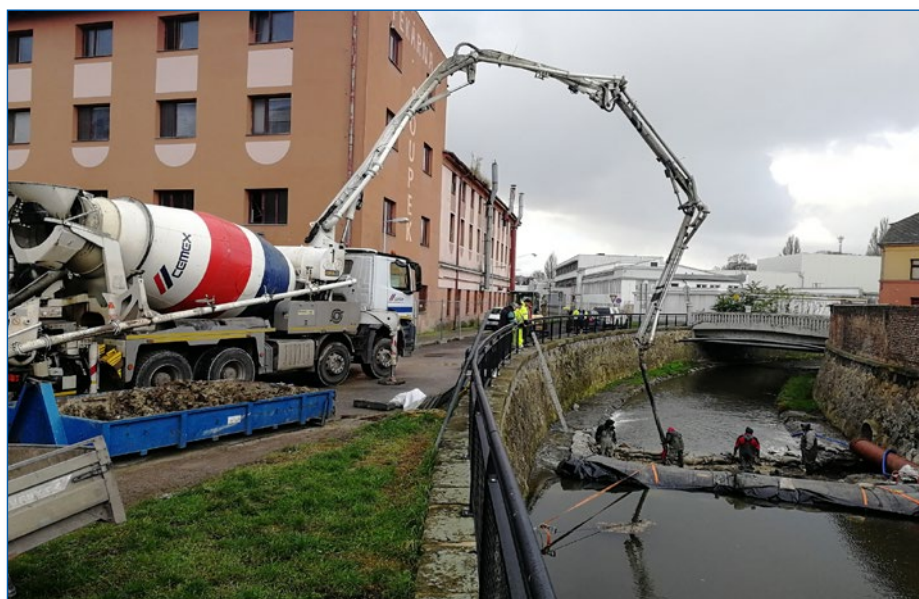
Mladá Boleslav, Nádražní ulice – opravy kanalizační shybky pod Klenicí
