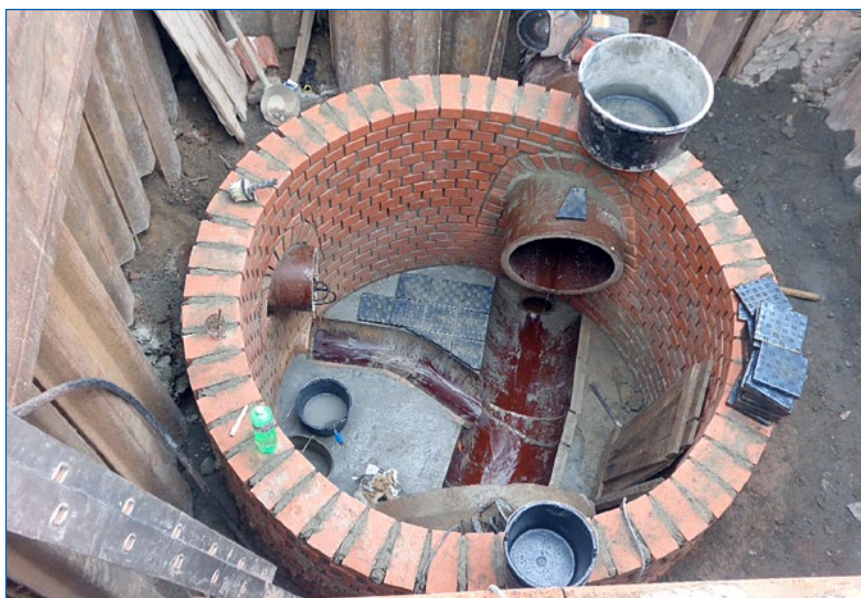
Kosmonosy, ulice K. Veselého – obnova kanalizace
