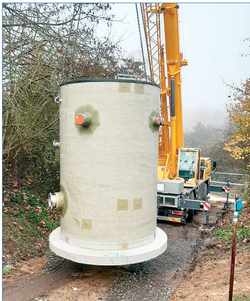
Hrdlořezy – montáž čerpací stanice se separací
