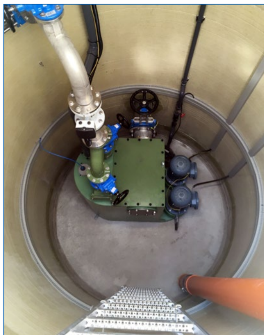
Ptýrov, čerpací stanice odpadních vod I a výtlač – technologie se separací usaditelných látek
