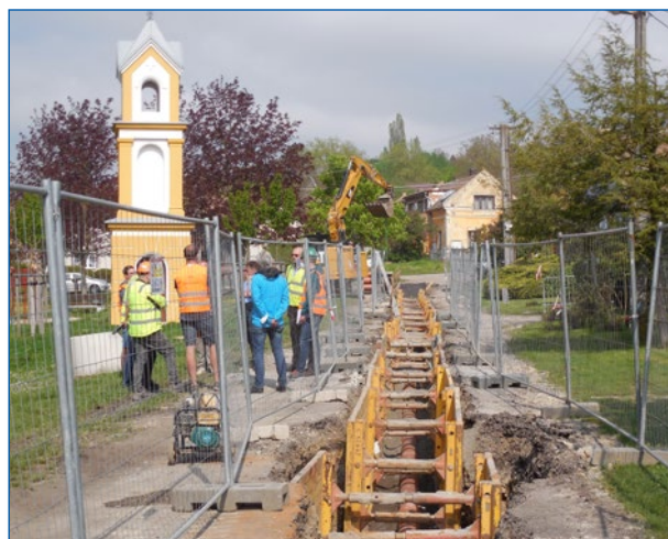
Úherce – výstavba kanalizační stoka A2
