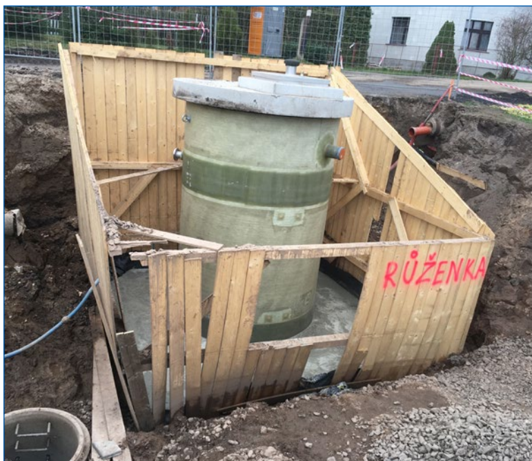
Ptýrov, čerpací stanice odpadních vod I a výtlač – technologie se separací usaditelných látek
