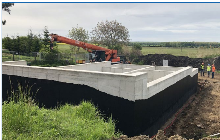
Semčice, intenzifikace ČOV, nové nádrže po betonáži
