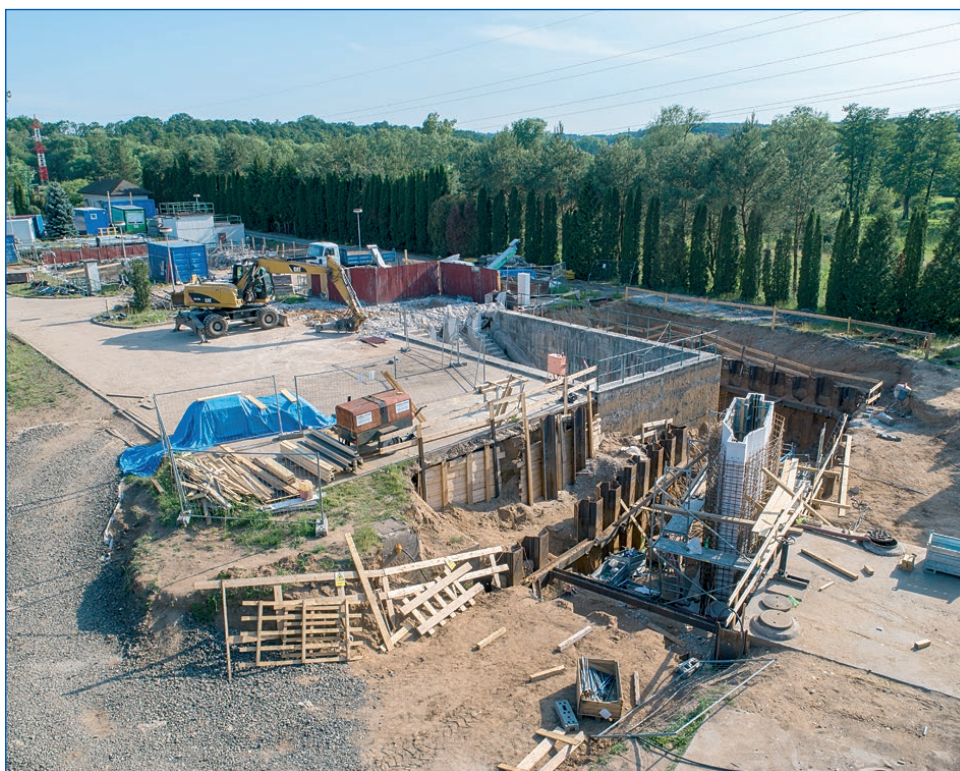
Výstavba nové čerpací stanice
