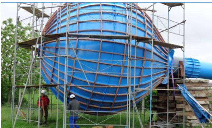
Nová koule s přípravou na zateplení
