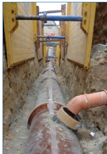
Mnichovo Hradiště, provizorní odvádění odpadních vod během stavby
