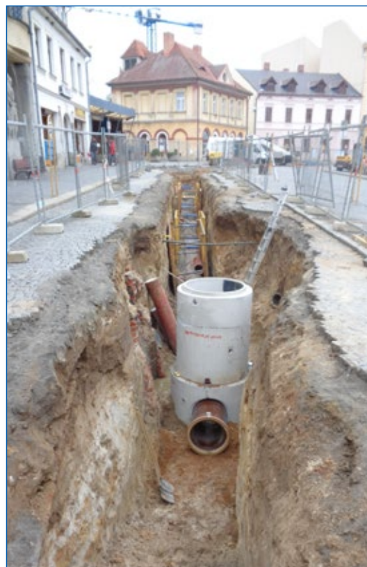
Mnichovo Hradiště, Masarykovo náměstí – pokládka kanalizace
