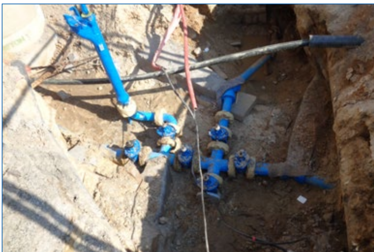
Mnichovo Hradiště, výměna armaturního uzlu na vodovodu
