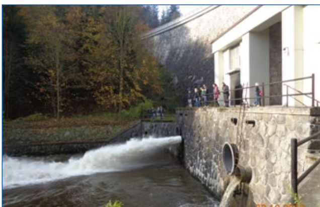
Zkouška funkčnosti výpustí
