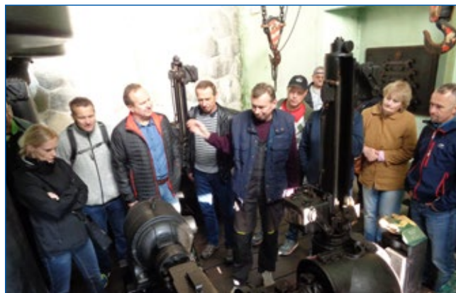
Strojovna výpustí přehradního tělesa
