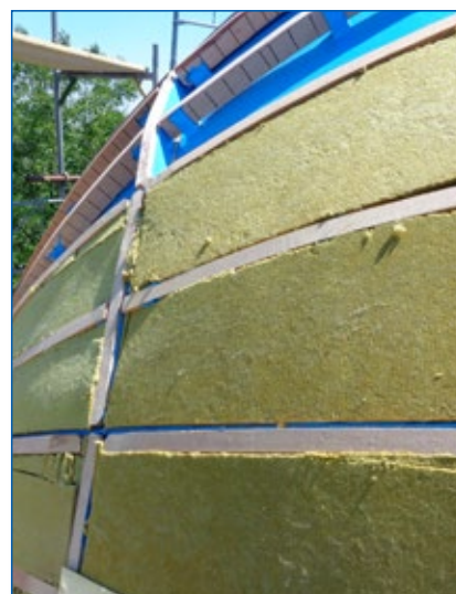
Detail tepelné izolace
