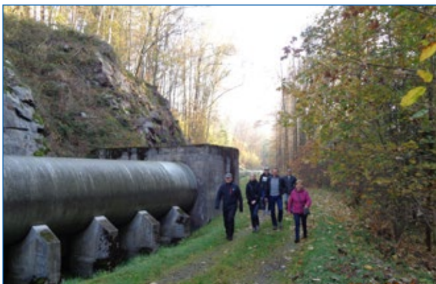
Gravitační potrubí nátoky do elektrárny
