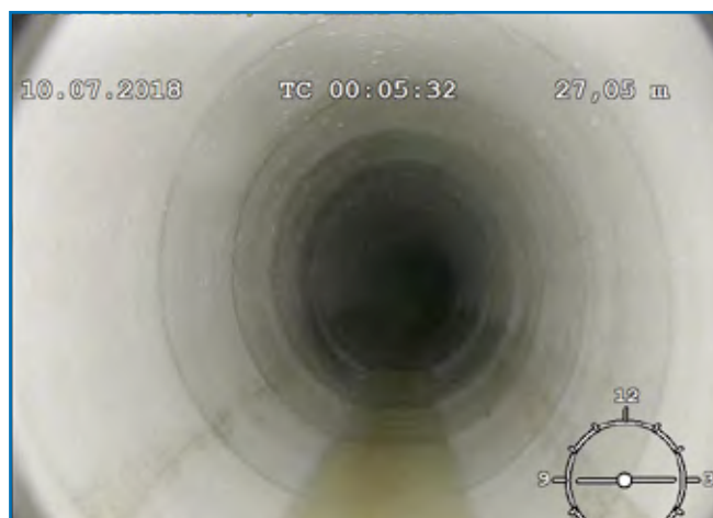
Stoka po sanaci
