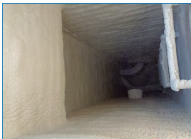
Šachta po sanaci
