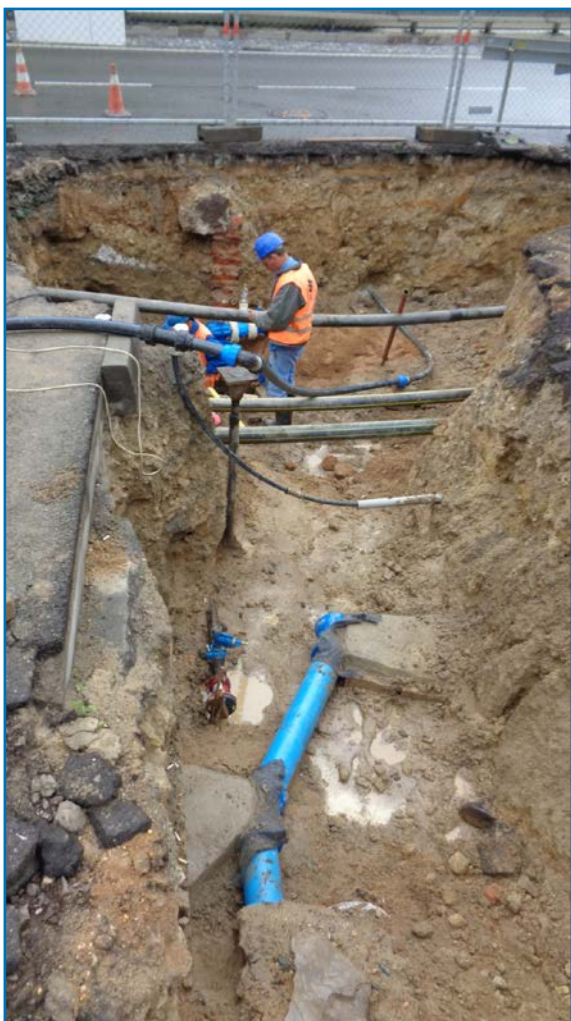
Mladá Boleslav, ul. V Rokli –obnova vodovodního řádu
