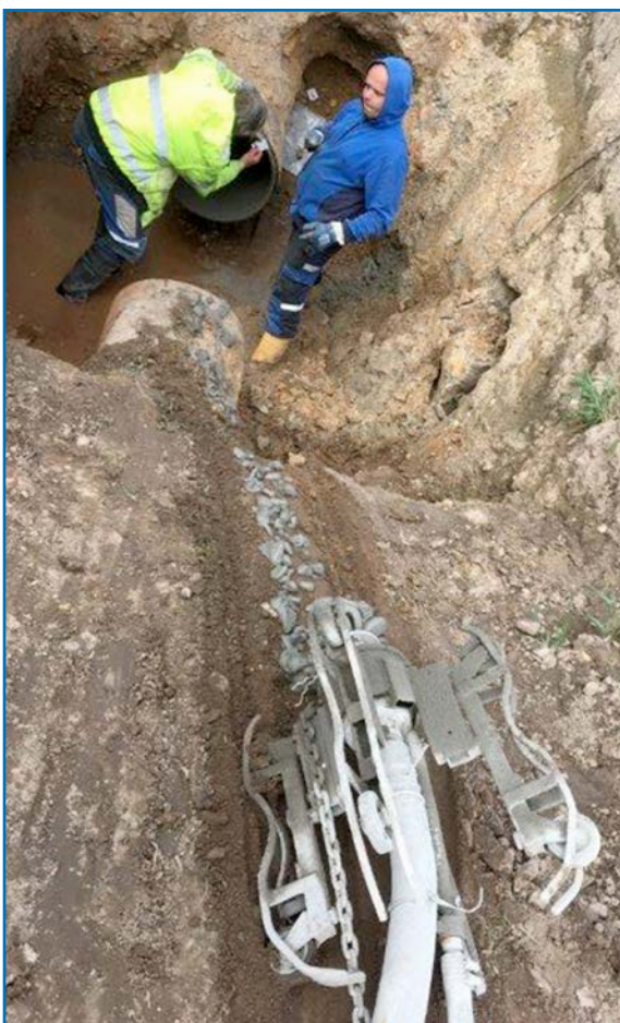
Skupinový vodovod Mladá Boleslav – cementace potrubí
