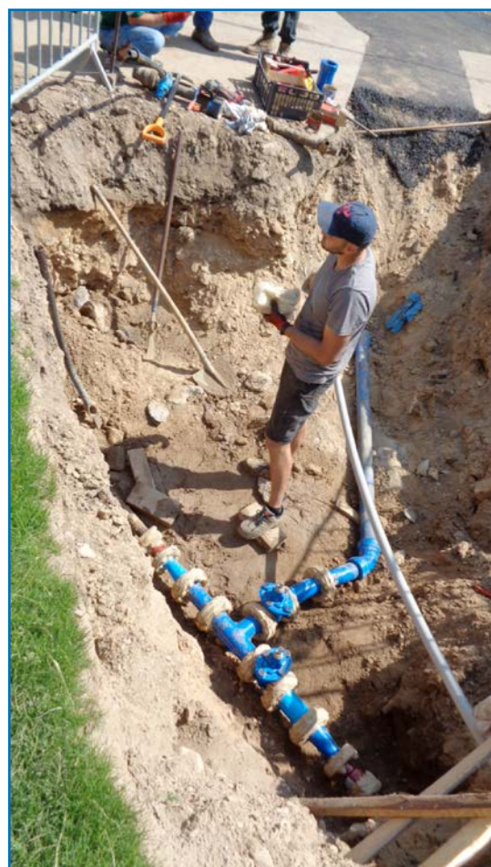
Velké Všelisy, lokalita Peklo – obnova vodovodu
