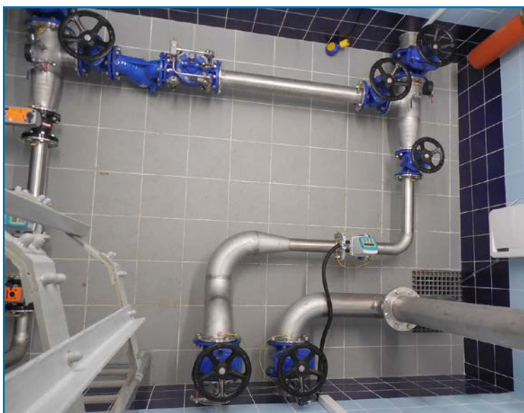
Brodce – rekonstrukce zemního vodojemu
