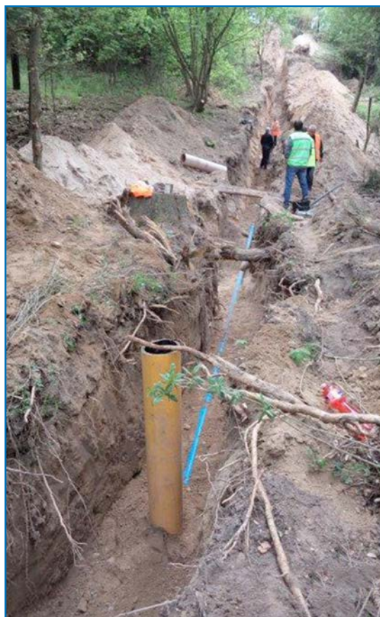
Bílá Hlina – výměna výtlačného řadu
