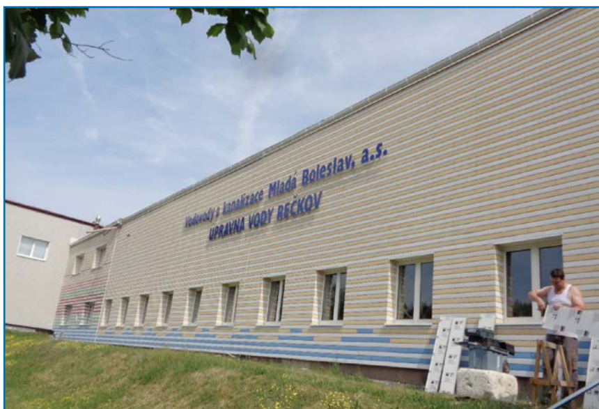
Rečkov, úpravna vody
