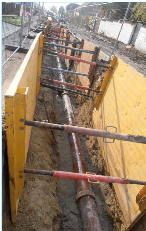
Benátkách nad Jizerou, ul. Kvapilova – výměna kanalizační stoky
