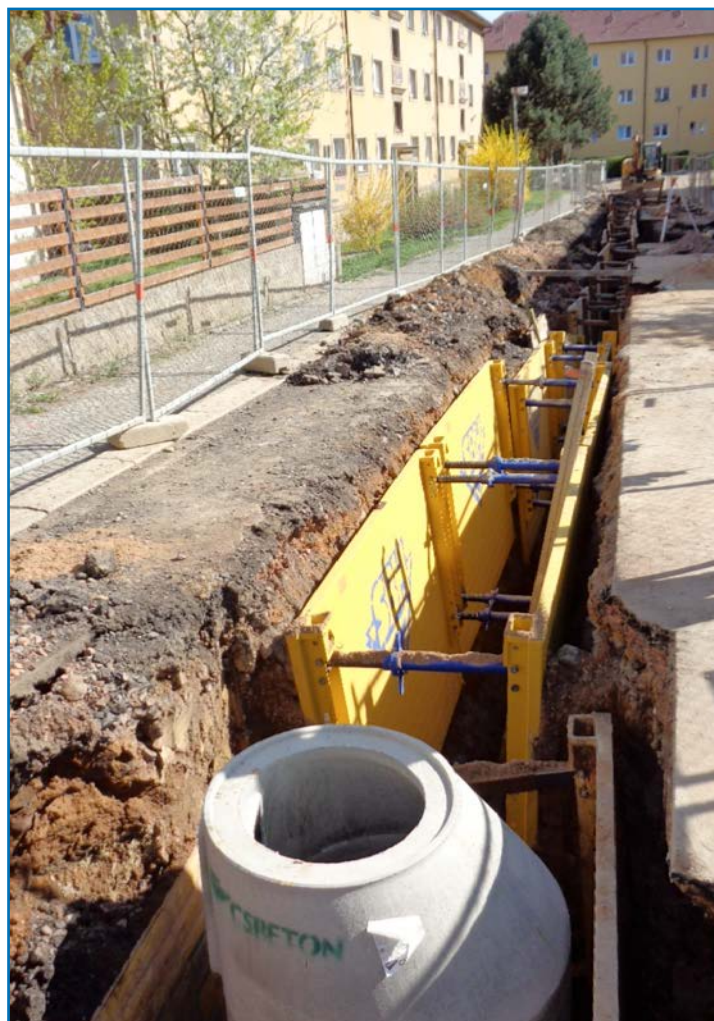
Mnichovo Hradiště, ul. S. K. Neumanna – obnova vodovodu a kanalizace
