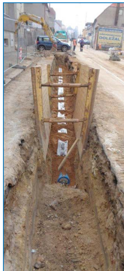
Mladá Boleslav, ul. Ptácká – výměna stávajícího vodovodního řadu
