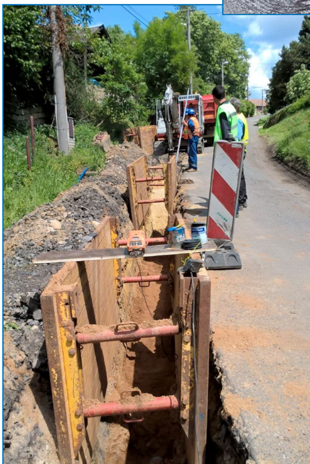
Březovice, výměna vodovodních řadů
