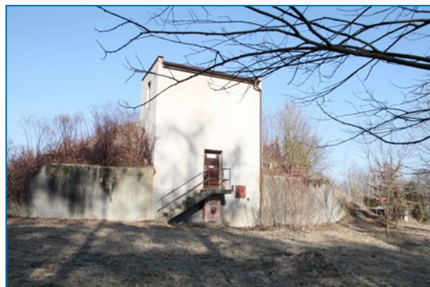
Žerčice, zemní vodojem
