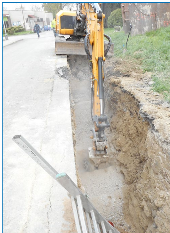
Krpy, obnova vodovodu
