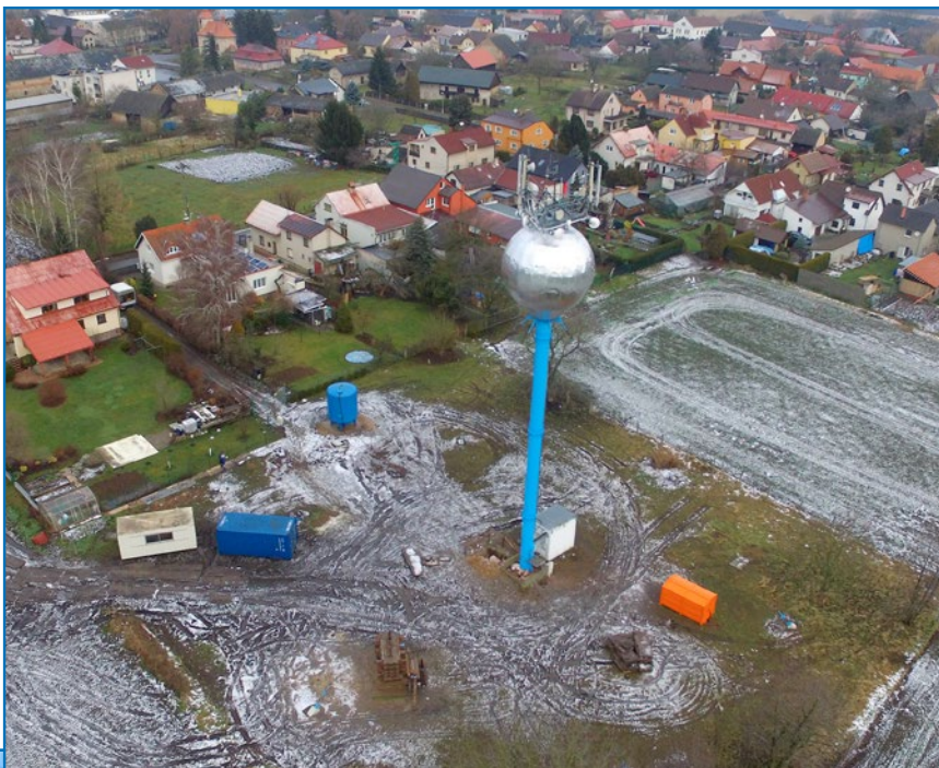
Bukovno, věžový vodojem – oprava
