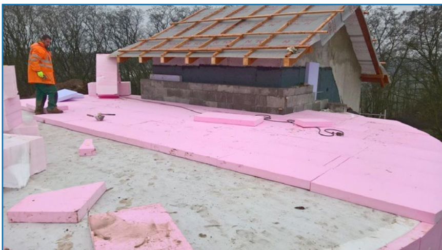
Brodce, zemní vodojem - rekonstrukce
