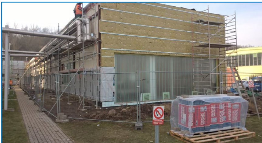
Mladá Boleslav, ČOV II - Podlázky - rekonstrukce objektu kalového hospodářství
