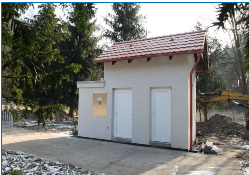
Skalsko, čerpací stanice - rekonstrukce
