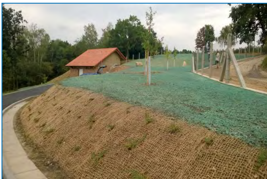
Kněžmost, zemní vodojem – ve stavbě a před dokončením
