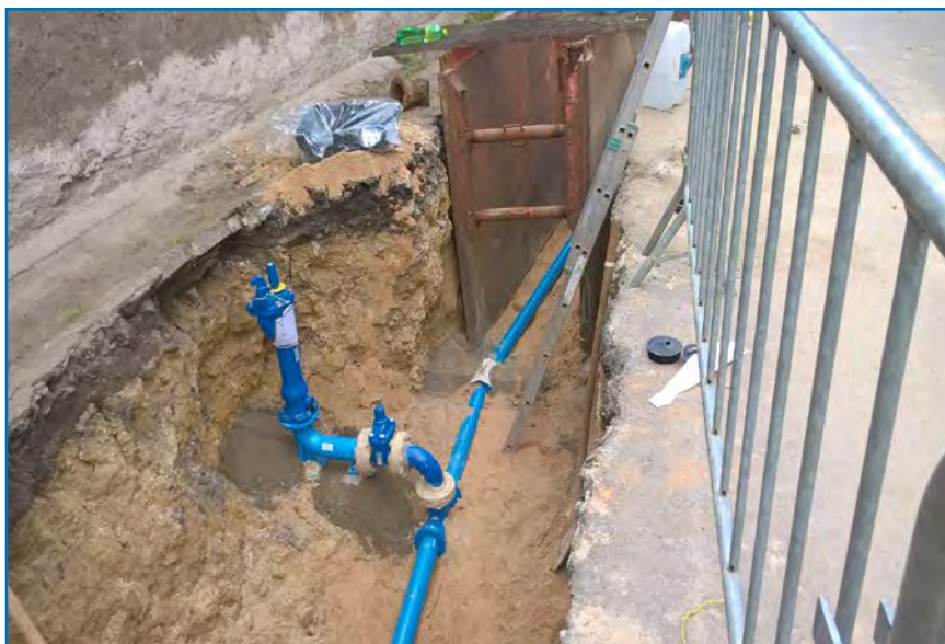
Krpy, rekonstrukce vodovodních řadů
