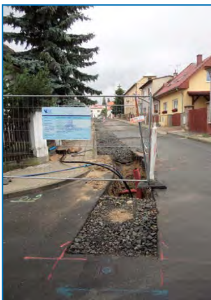
Benátky nad Jizerou, ulice Jiráskova – výměna vodovodního řadu
