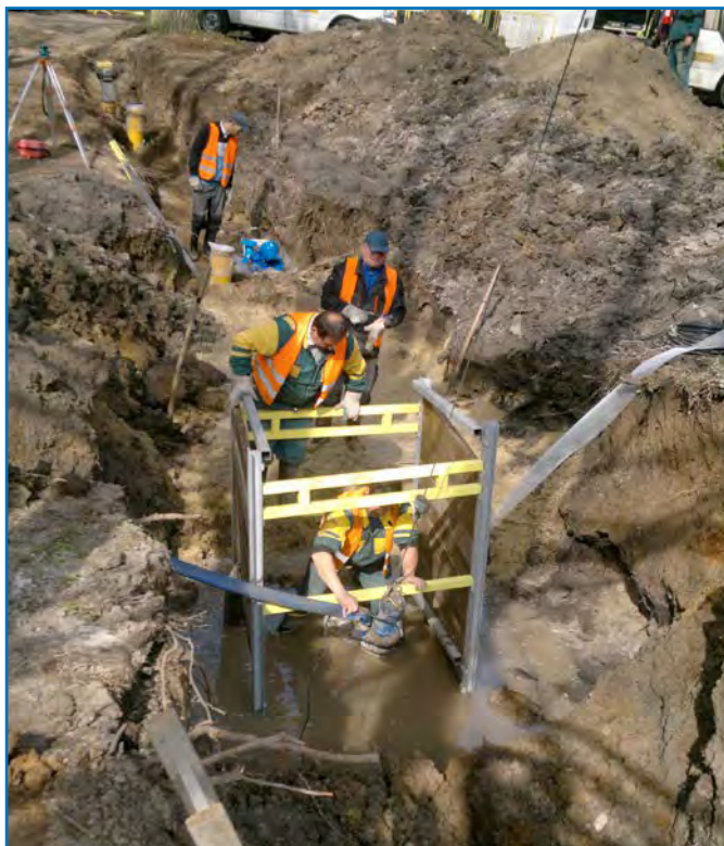
► Klášter Hradiště – výměna výtlačného řadu
