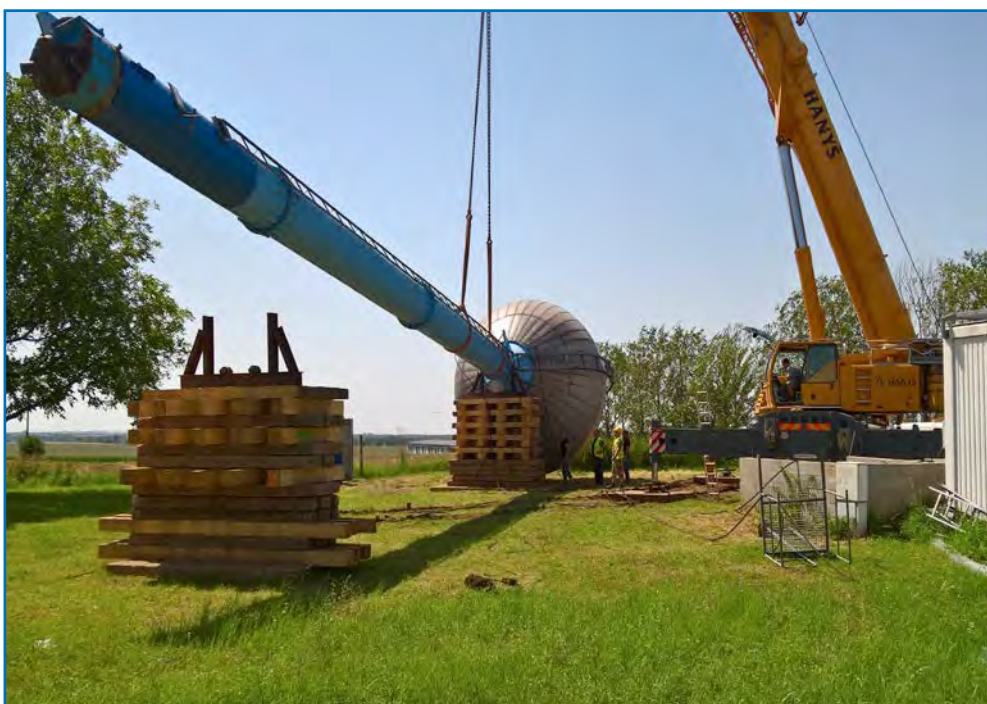
Bukovno, rekonstrukce věžového hydroglobu
