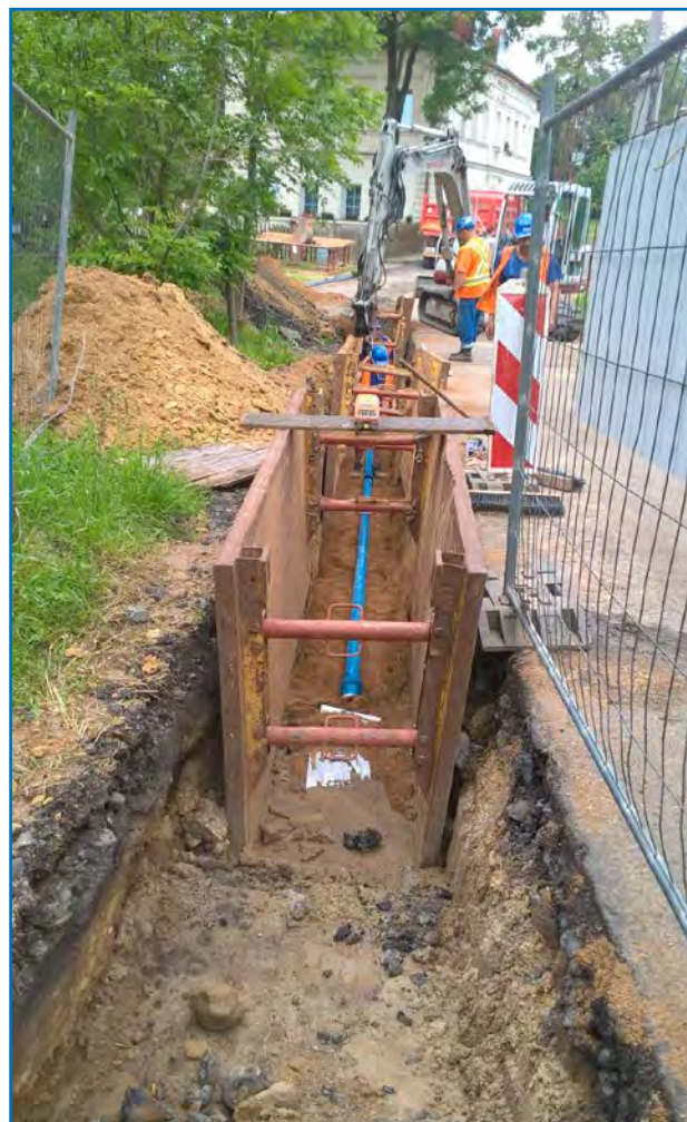
Březovice, výměna vodovodních řadů
