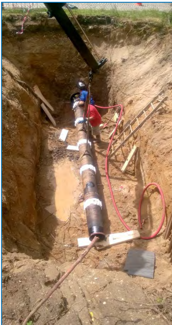
Benátky nad Jizerou - Jiřice, cementace řadu DN 500 mm
