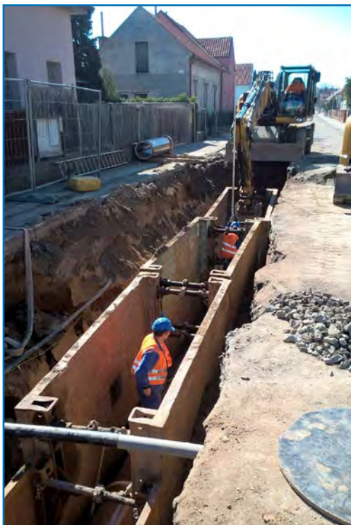
►► Benátky nad Jizerou, ulice V Záhrádkách – výměna kanalizace
