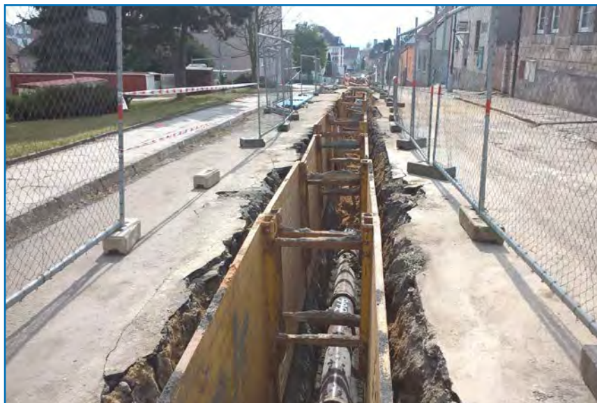
Dobrovice, ulice Husova – obnova kanalizace
