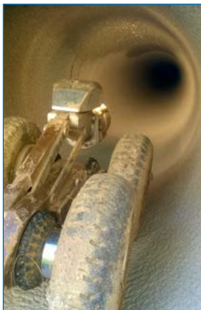
Benátky nad Jizerou – cementace vodovodního řadu OC500 mm – kamerová prohlídka po opravě a montáži kalniku
