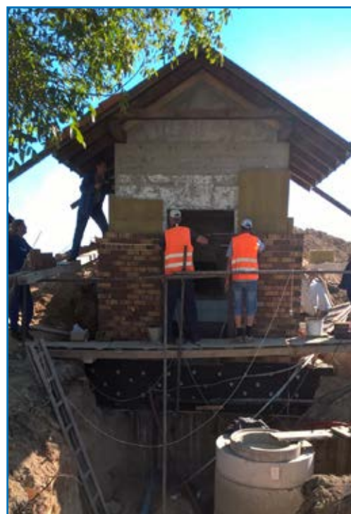
Kropáčova Vrutice – rekonstrukce vodojemu
