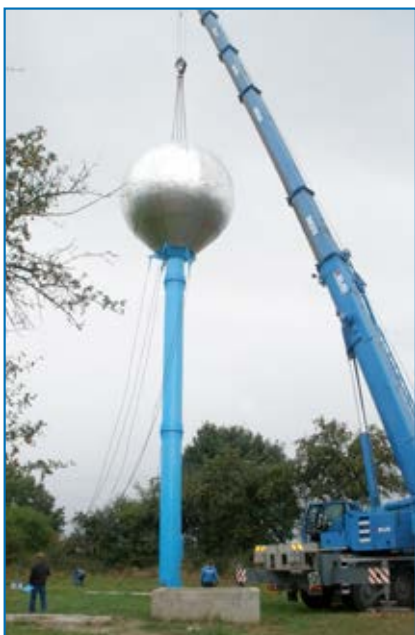
Jizerní Vtelno – oprava vodojemu
