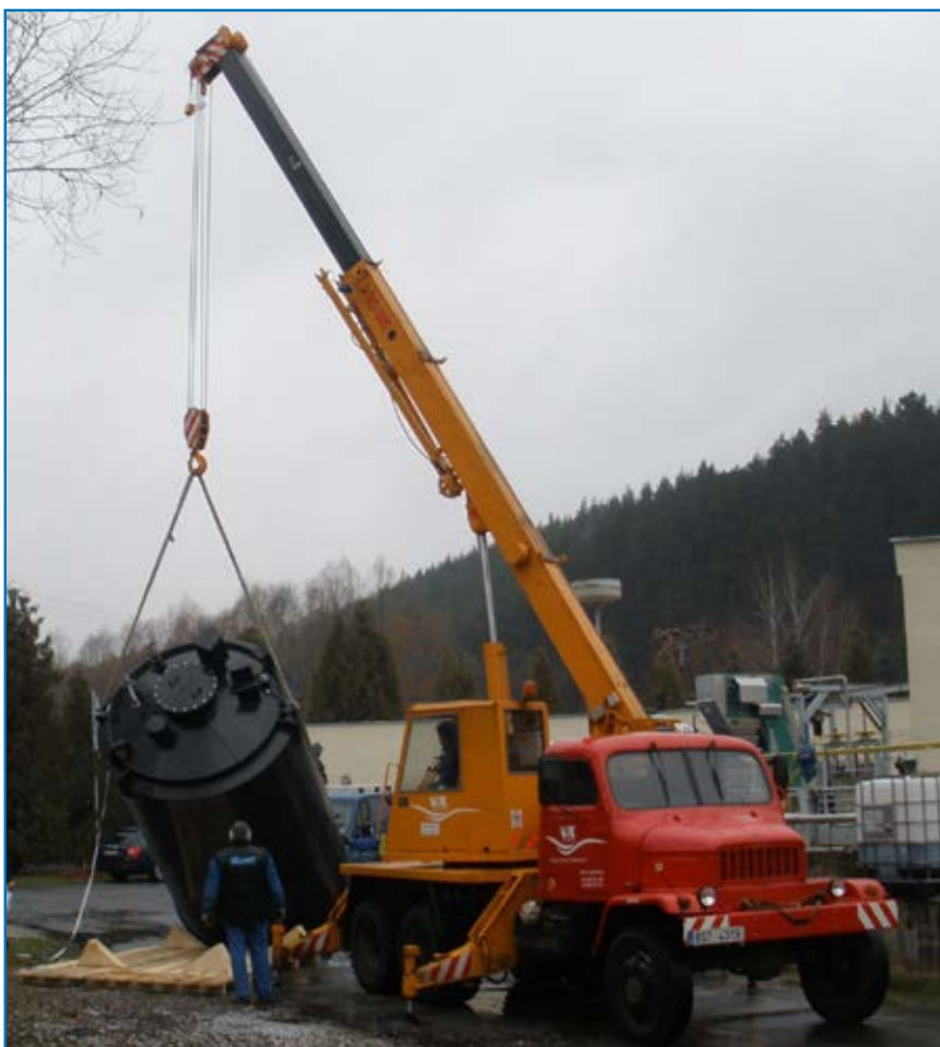
Bělá pod Bezdězem – ČOV – osazování nádrže na dávkování síranu
