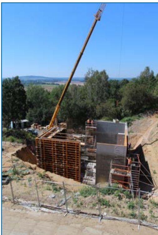
Kněžmost – bednění a betonáž akumulční nádrže vodojemu
