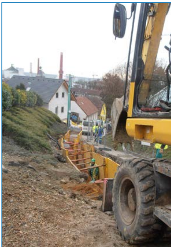
Dobrovice, Vinařická ulice – obnova vodovodu a kanalizace
