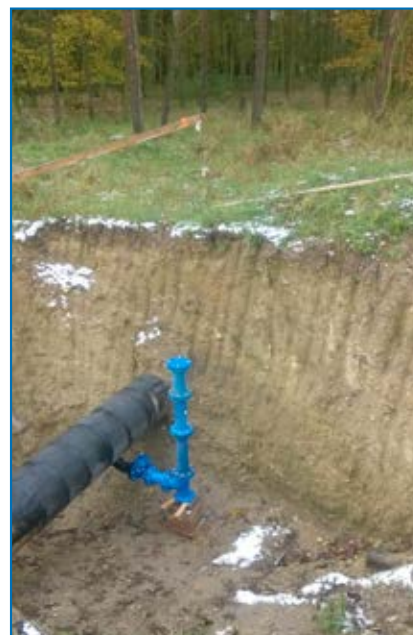
Benátky nad Jizerou – cementace vodovodního řadu OC500 mm – kamerová prohlídka po opravě a montáži kalniku
