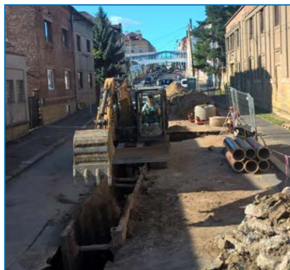
Mladá Boleslav, Palackého ulice – oprava kanalizace
