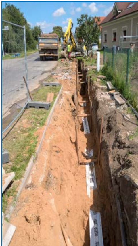
Dolní Stakory – obnova vodovodu
