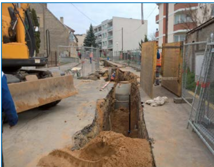
Dobrovice, Husova ulice – pokládka kanalizace
