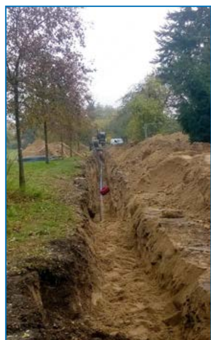
Jemníky – rekonstrukce vodovodního přivaděče
