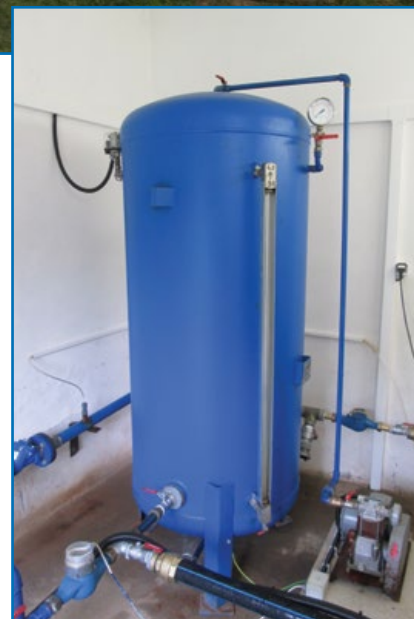
Osazení provizorní nádrže v blízkosti čerpací stanice v samém středu obce. Snímek interiéru čerpací stanice zachycuje stávající tlakovou nádrž (tzv. darling) a nově osazenou soustavu čerpadel Hydrovar.
