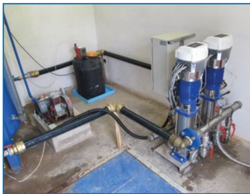
Osazení provizorní nádrže v blízkosti čerpací stanice v samém středu obce. Snímek interiéru čerpací stanice zachycuje stávající tlakovou nádrž (tzv. darling) a nově osazenou soustavu čerpadel Hydrovar.
