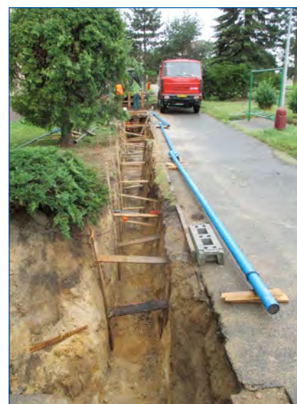
Mladá Boleslav, ulice Na Radouči – výměna vodovodního řadu
