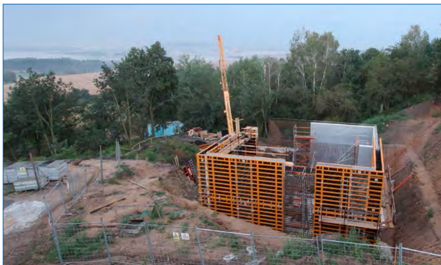
Kněžmost, zemní vodojem
