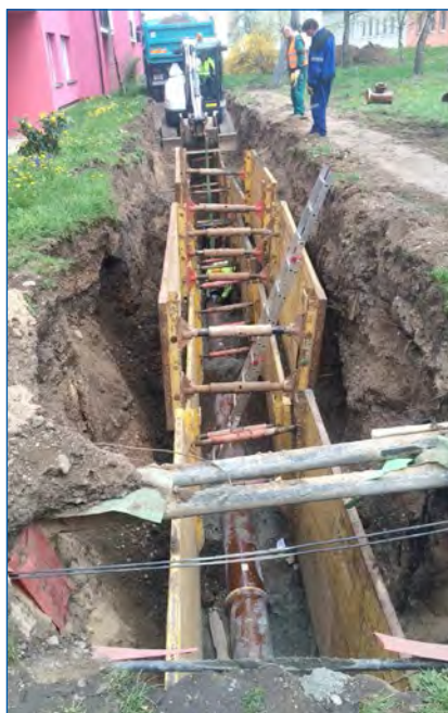
Benátky nad Jizerou, ulice Ořechová – rekonstrukce kanalizace
