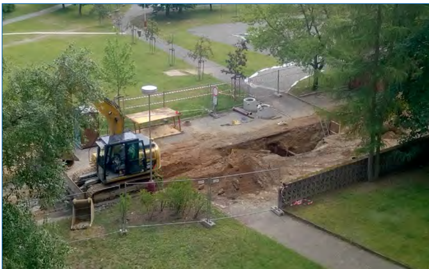
Mladá Boleslav, vnitroblok ulice Jana Palacha – výměna vodovodního řadu
