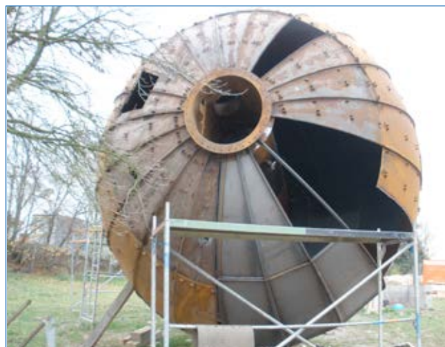
Pohled na stávající stav nádrže po odstranění krytiny a tepelné izolace. Byla zjištěna pokročilá koroze horní části koule svařené z plátů 4 mm. Po otryskání povrchu byla zjištěna u plátů 4 mm koroze v celé tloušťce. Operativně bylo rozhodnuto o výměně ocelových plátů celé horní poloviny nádrže. Na snímku vpravo je část plátů po výměně.
