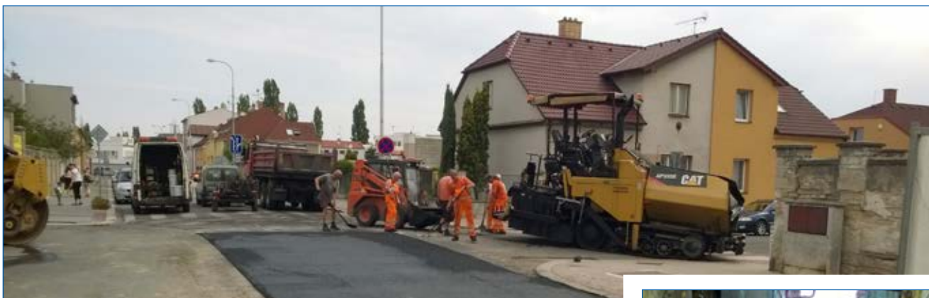
Mladá Boleslav, Laurinova ulice - obnova vozovky po obnově kanalizace
