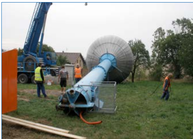
Po uvolnění kotvicích lan byl vodojem položen za pomoci velkotonážního jeřábu. Pro zajímavost: hmotnost prázdného vodojemu byla dle diagnostiky jeřábu 20 tun.
