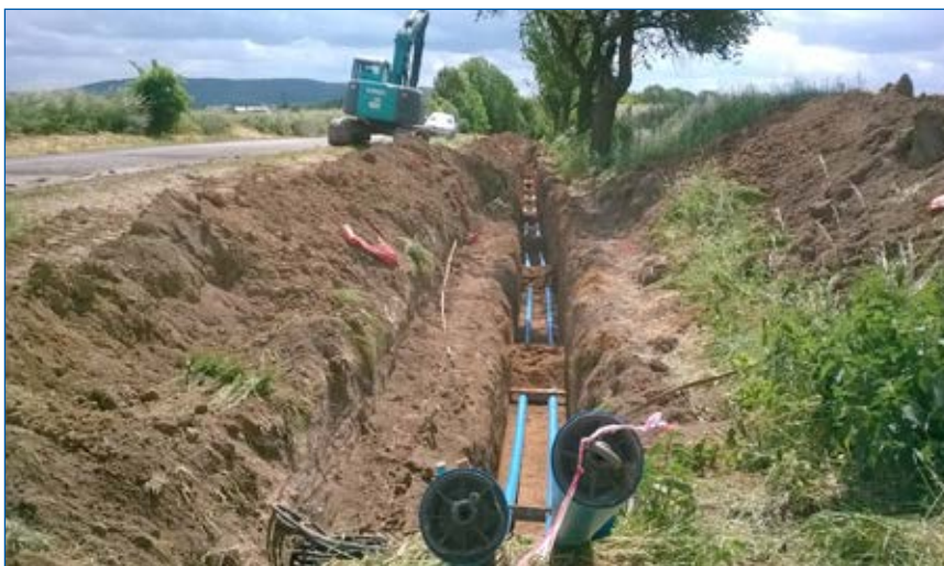
Vinec - rekonstrukce vodovodu a řešení tlakových poměrů
