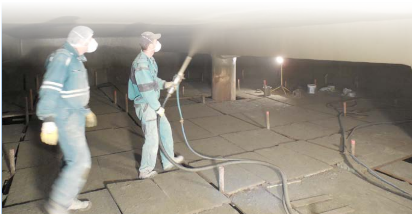
Bradlec sanace vodní komory zemního vodojemu
