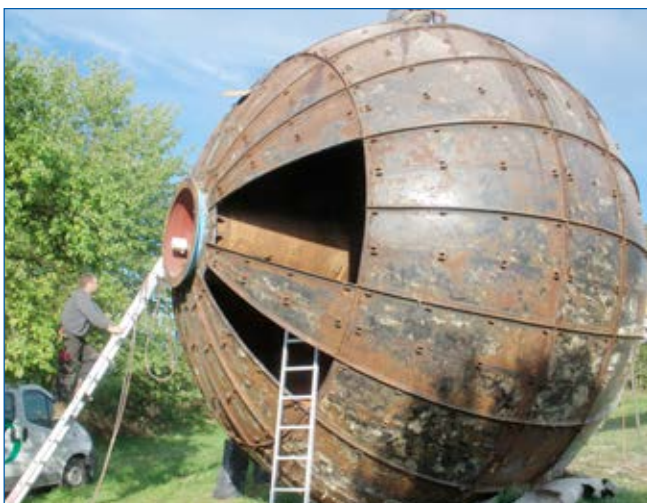
Pohled na stávající stav nádrže po odstranění krytiny a tepelné izolace. Byla zjištěna pokročilá koroze horní části koule svařené z plátů 4 mm. Po otryskání povrchu byla zjištěna u plátů 4 mm koroze v celé tloušťce. Operativně bylo rozhodnuto o výměně ocelových plátů celé horní poloviny nádrže. Na snímku vpravo je část plátů po výměně.
