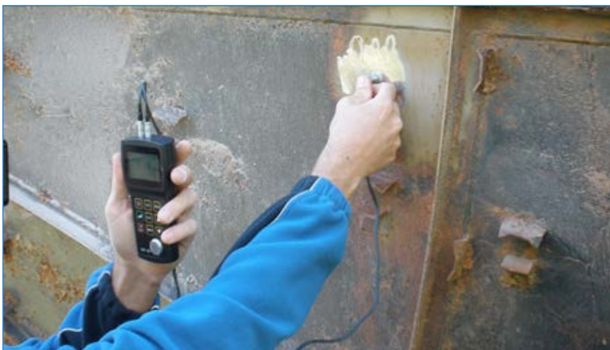
Odborné měření stávající tloušťky pláště vodojemu. Původní nádrž vodojemu byla svařena z ocelových plátů tloušťky 8 mm, 6 mm a 4 mm.
