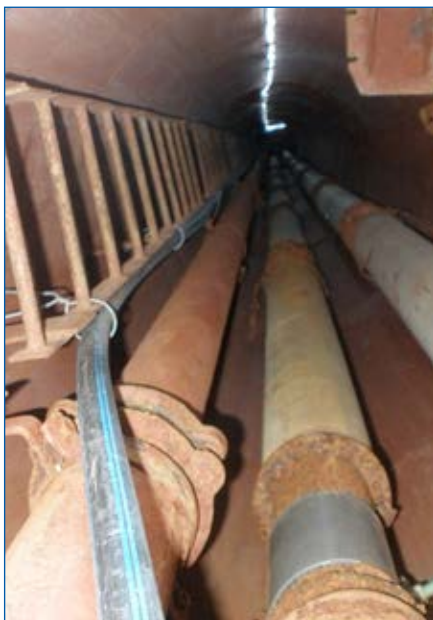
Pohled do nohy vodojemu s původním přívodním, zásobním a odpadním potrubím, které bylo vyměněno za nerez provedení.
