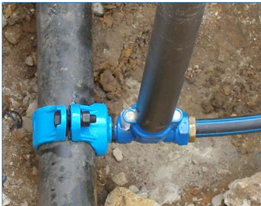
Nová vodovodní přípojka
