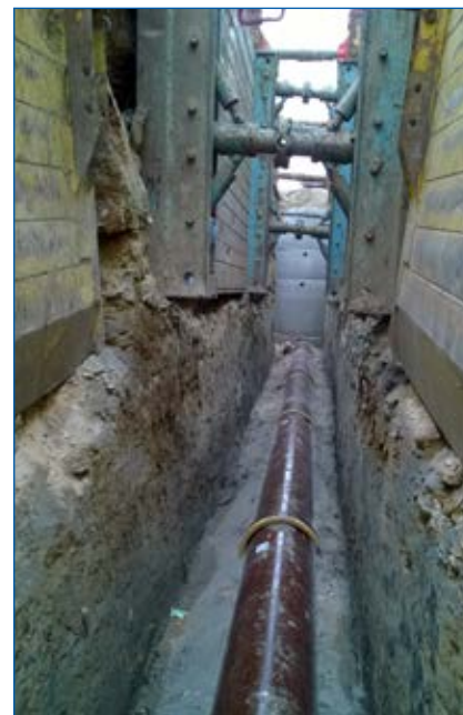
Mladá Boleslav, Bezručova ulice - oprava vodovodu a kanalizace
