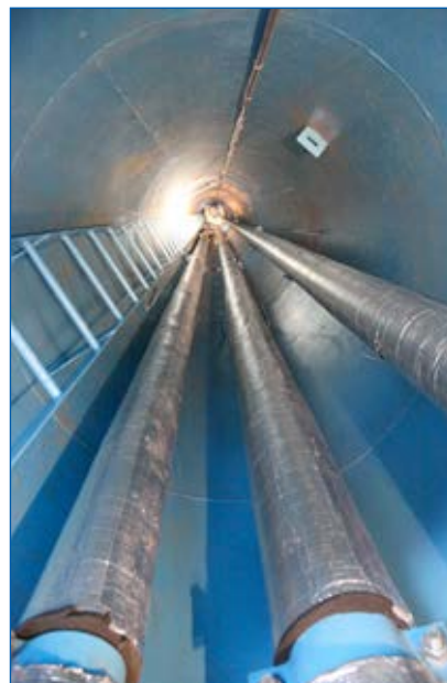
Pohled do nohy vodojemu s původním přívodním, zásobním a odpadním potrubím, které bylo vyměněno za nerez provedení.
