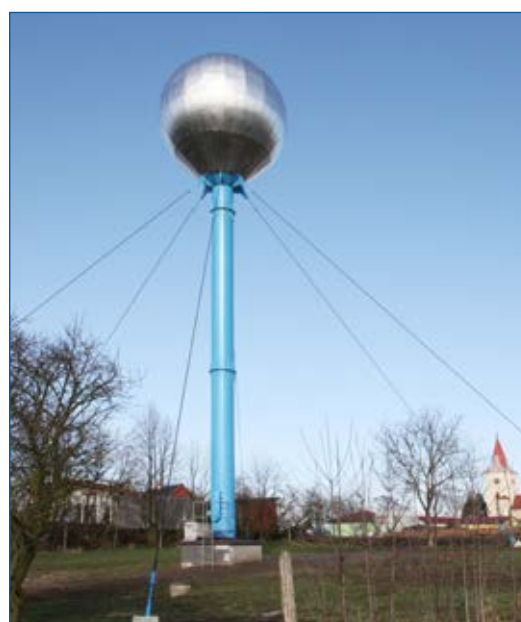
Vodojem po rekonstrukci opět stojí.
