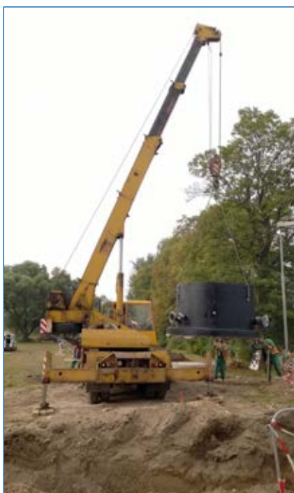
Koprník, osazení distriktní šachty
