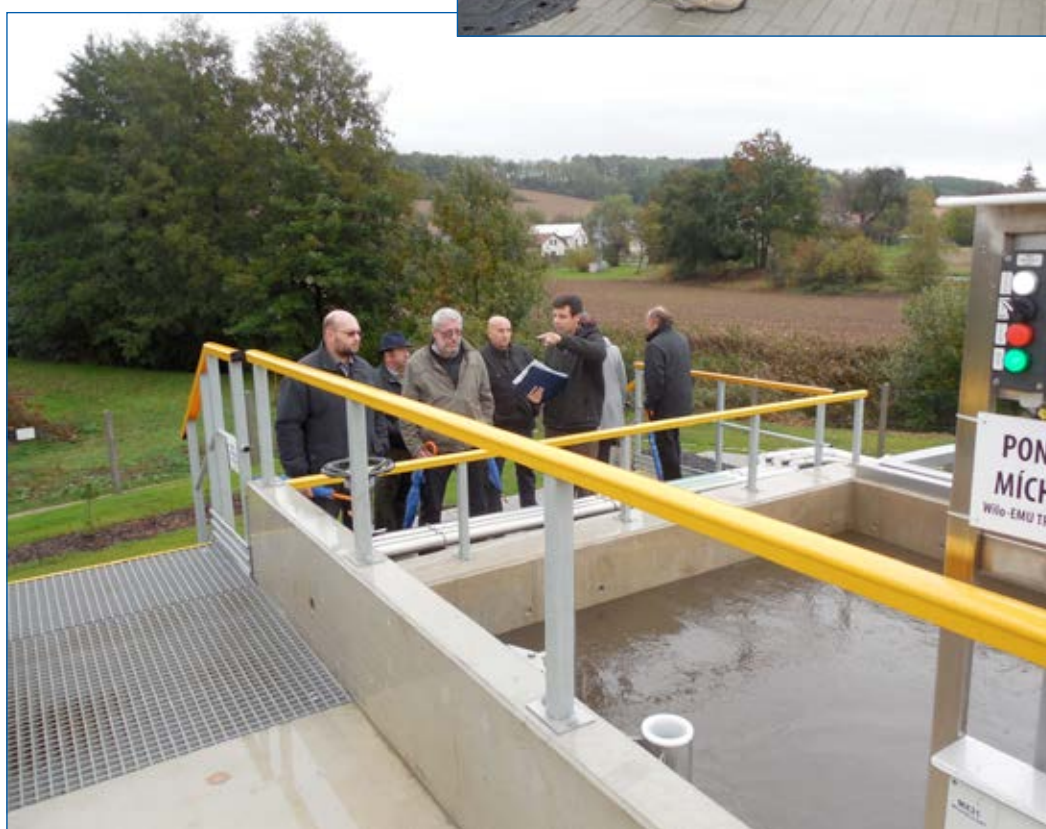
Kněžmost, čistírna odpadních vod
