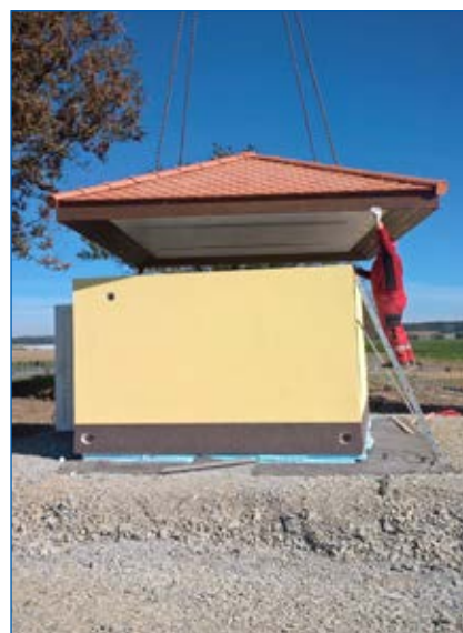
Koprník, osazení krovu na přečerpací stanici
