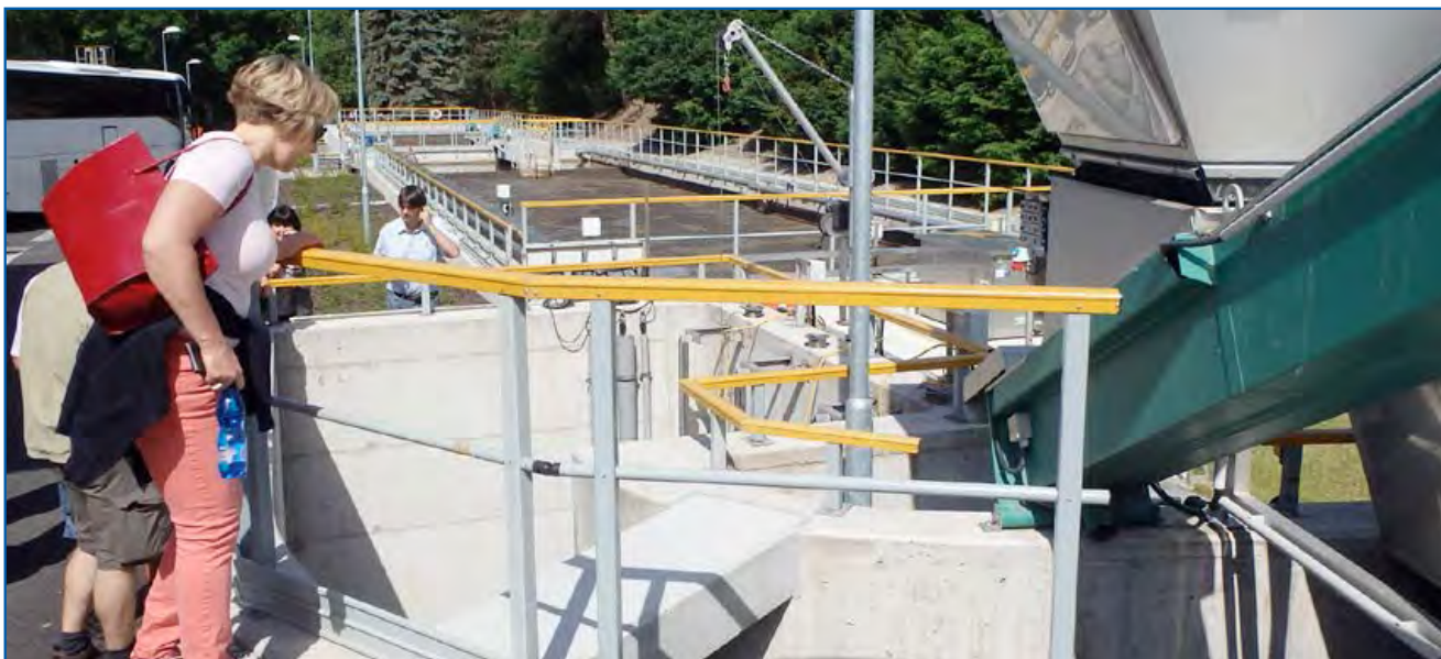
Mnichovo Hradiště, čistírna odpadních vod
