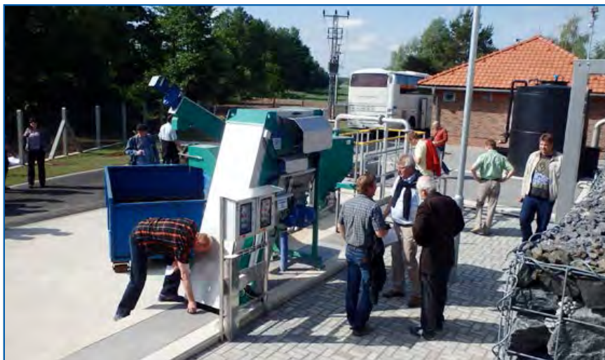
Kněžmost, čistírna odpadních vod
