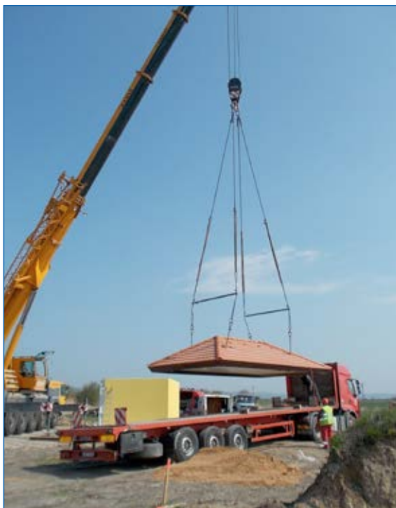
Jižní skupina, montáž nové přečerpací stanice v obci Luštěnice
