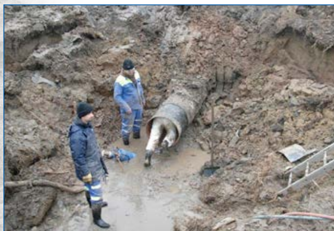
Bakov nad Jizerou – Podhradí, nouzové napojení
