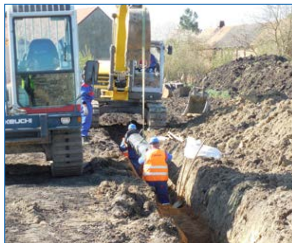
Jižní skupina, vodovod - pokládka potrubí DN 300 mm u obce Němčice
