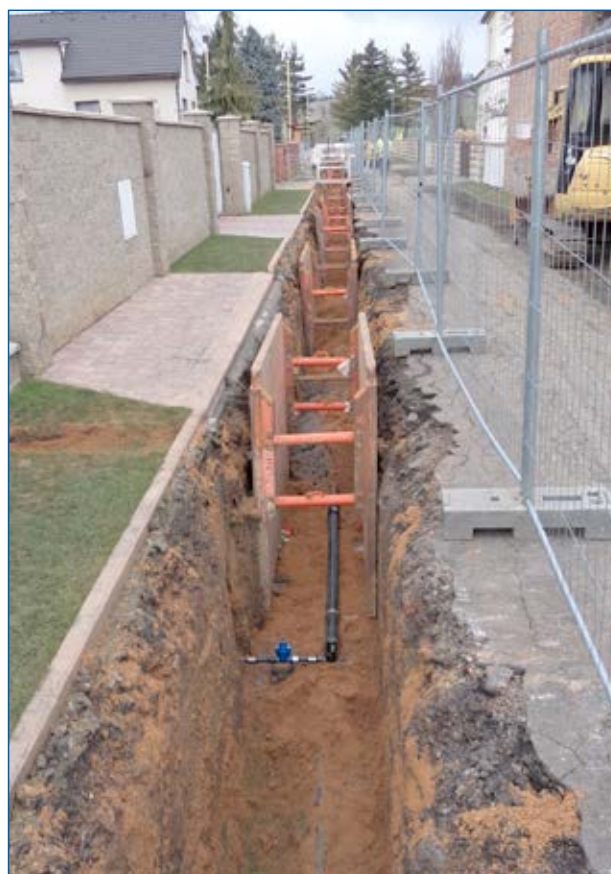
Semčice, výstavba vodovodního řádu
