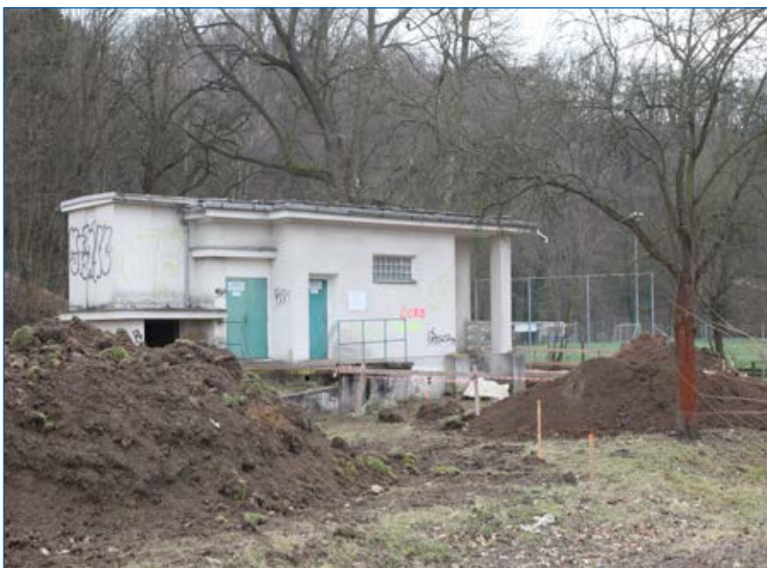
Benátky nad Jizerou – čerpací stanice I, původní stav
