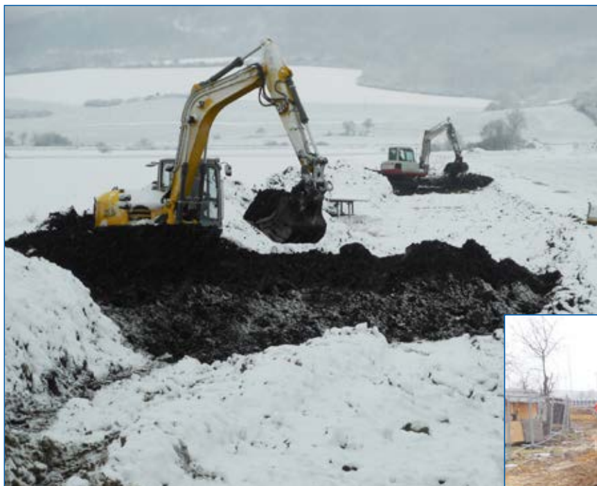
Jižní skupina, vodovod - pokládka vodovodu Libichov, rozprostírání ornice
