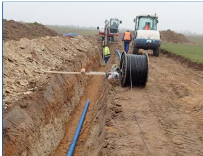
Jižní skupina, vodovod - pokládka přívaděče pro obec Písková Lhota
