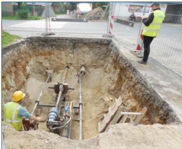
Jižní skupina, vodovod - podvrst po komunikaci v Pískové Lhotě
