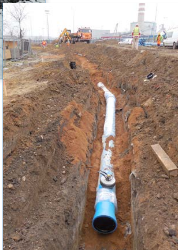
Mladá Boleslav, SV tangenta, propojovací vodovodní řad DN 300 mm
