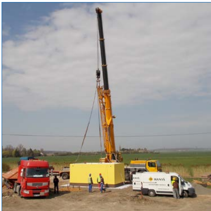
Jižní skupina, montáž nové přečerpací stanice v obci Luštěnice
