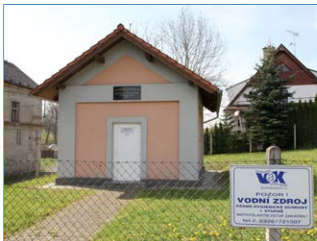
Vinec – čerpací stanice se zdrojem
