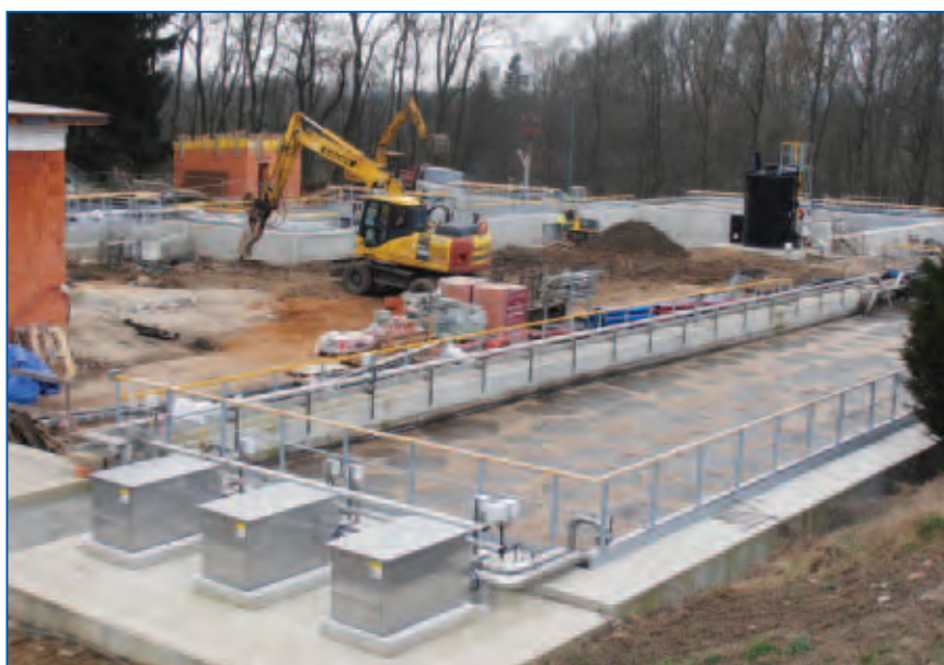
Mníchovo Hradiště, čistírna odpadních vod, zprovozněná aktivační nádrž
