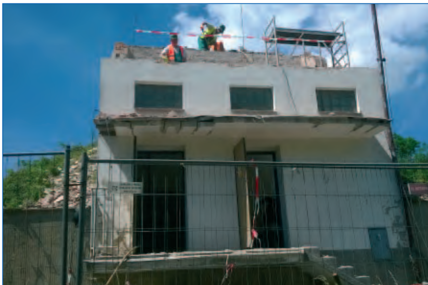
Vodojem Horní Stakory
