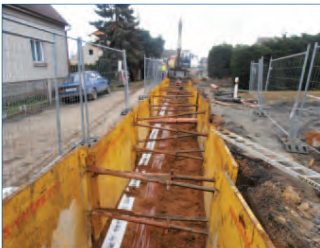
Gravitační stoka, výtlak z ČS OV a vodovod ve sdružené rýze
