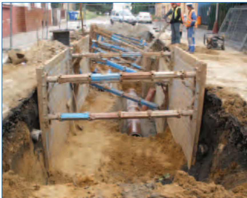
Mladá Boleslav Kollárova ul., obnova kanalizace současně s pokládkou nového vodovodního přívadče DN 400
