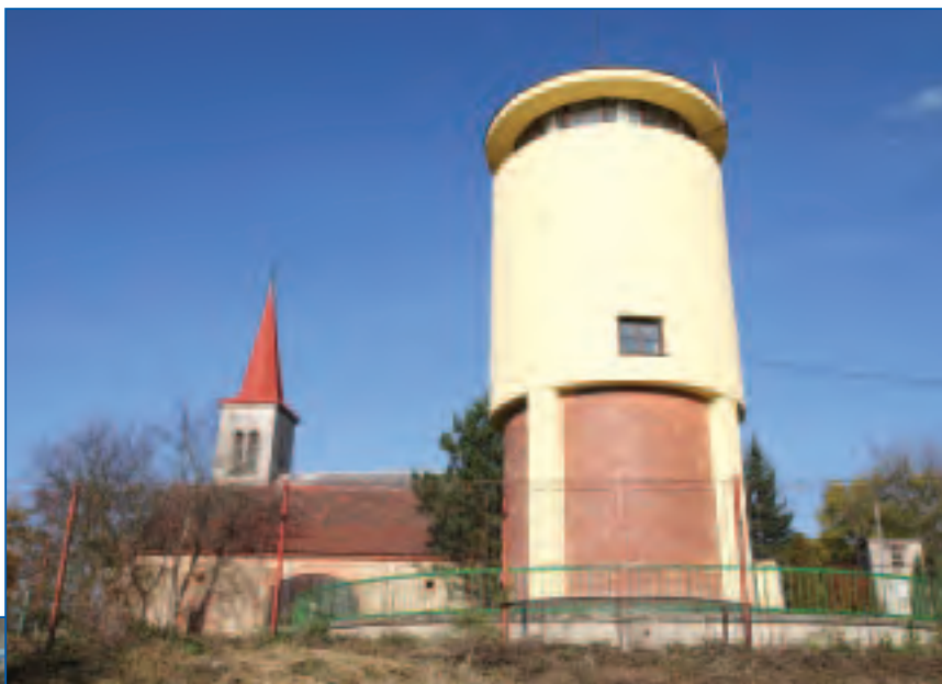
Bezdědice, vodojem po opravě
