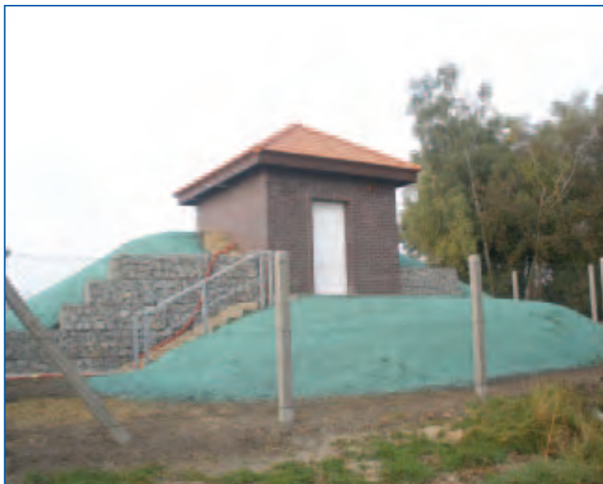
Malá Bělá, rekonstrukce vodojemu
