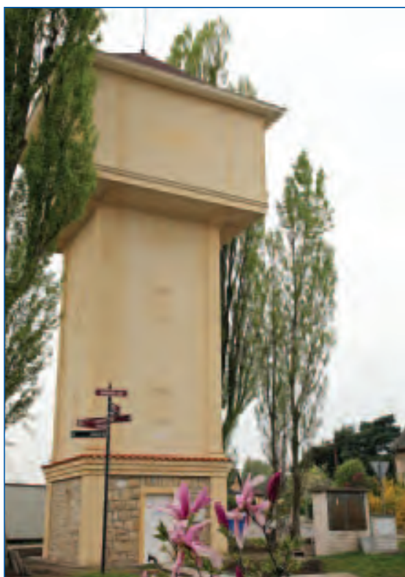
Čejetice, vodojem po opravě
