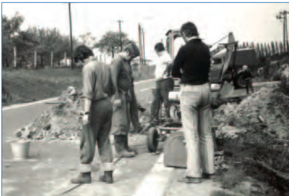
Čištění vodovodního řadu Bělá – Hlínoviště 1976, Antonín Tošovský druhý zleva
