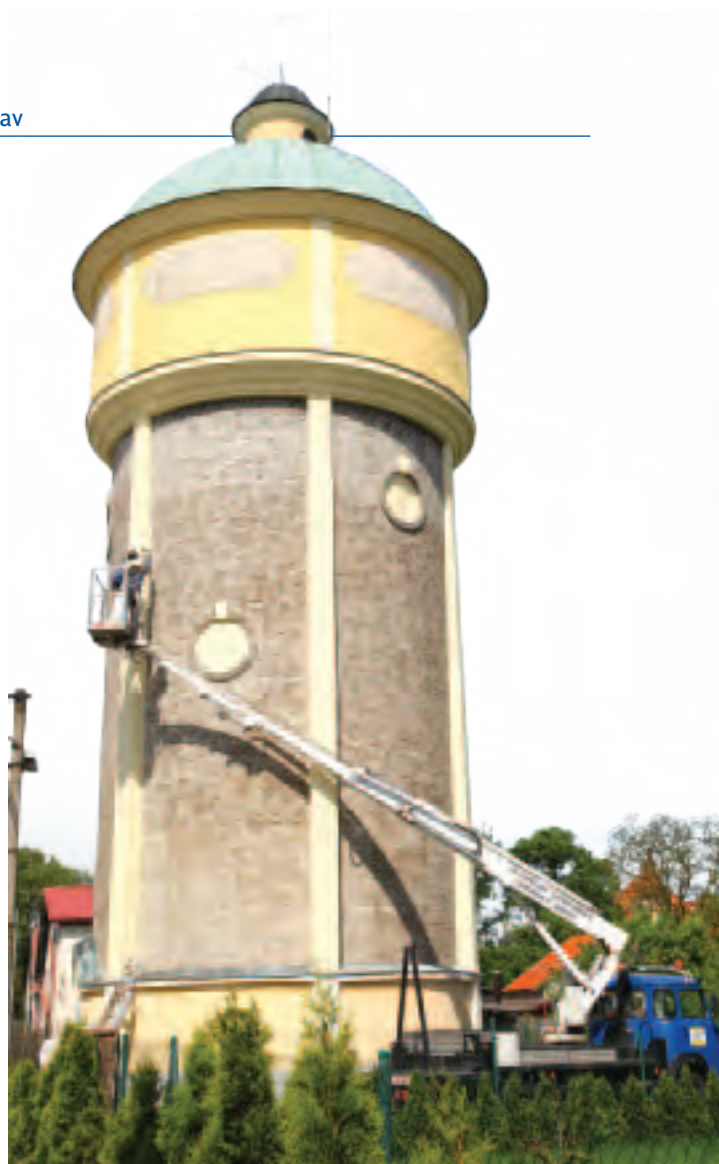
Bezno, oprava vodojemu
