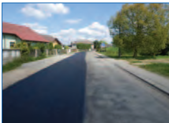
Bitouchov, oprava vozovky po provedení obnovy vod. řadů
