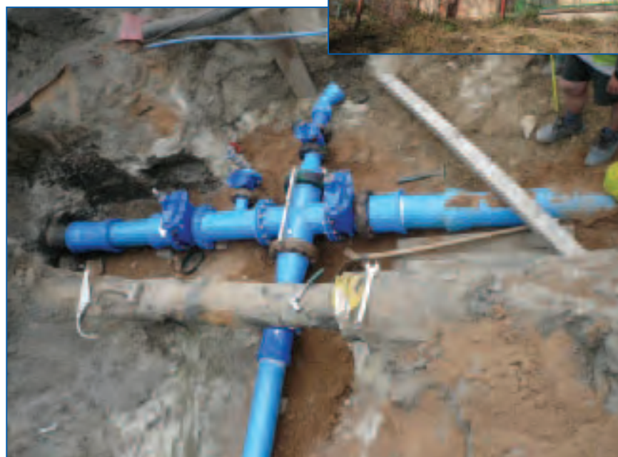
Mladá Boleslav, Jičínská ul., rekonstrukce vodovodu, armaturní uzel
