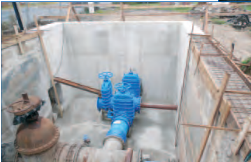
Dobruška řešení kvality pitné vody, rekonstrukce armaturní komory
