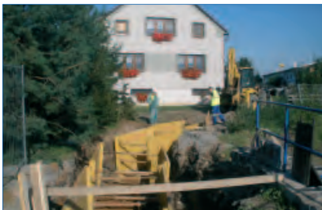
Chrást, výstavba kanalizační přípojky k objektu
