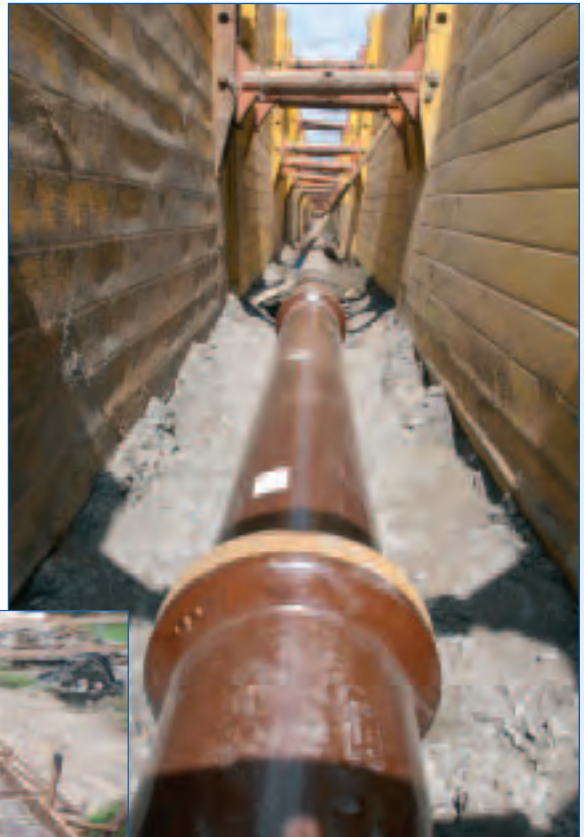
Bezděčín, pokládka kanalizace kamenina DN 250mm
