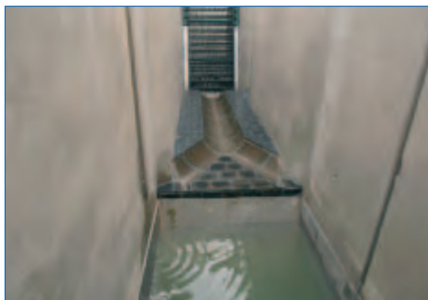
Mnichovo Hradiště ČOV, nový lapák šterku a nátok na hrubé česle
