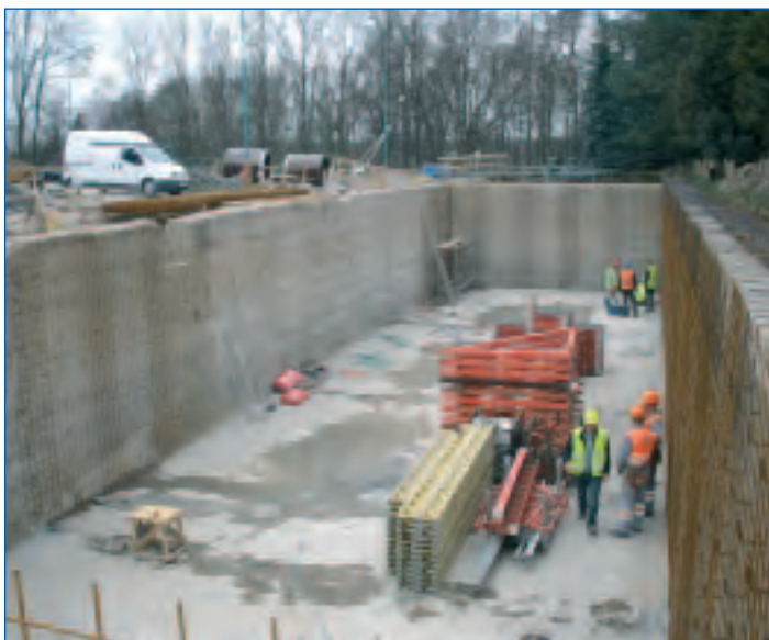
Mníchovo Hradiště, ČOV – příprava na přibetonování stěn
