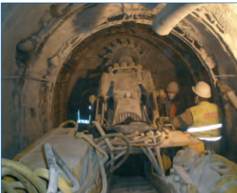
Mníchovo Hradiště, ČOV – důlní kombajn při zdolávání méně pevné skály
