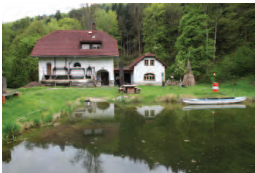
Buřinsko – čerpací stanice, dnes vodní elektrárna
