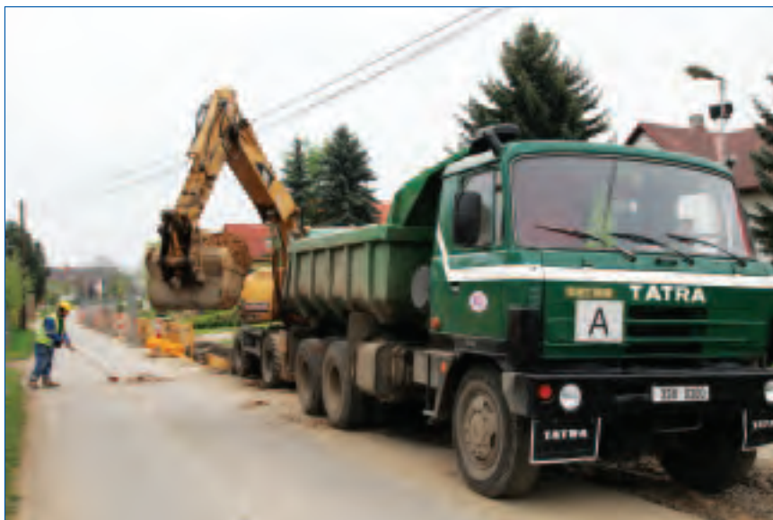
Líny, výstavba splaškové kanalizace
