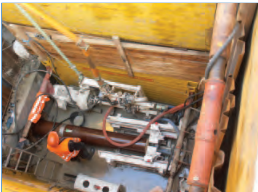
Chrát, dostavba kanalizace – startovací jímka pro bezvýkopovou pokládku kanalizace
