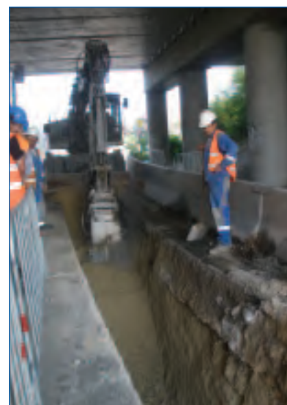
Dobrovice, vodovodní přivaděč – frézování skalního podloží pod R10
