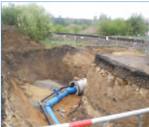
Dobruška, vodovodní přívaděč – podchod trati ČD
