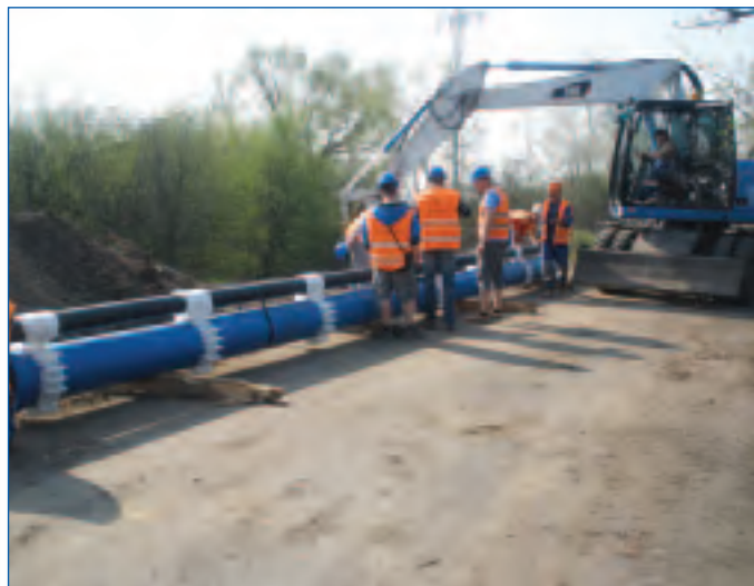
Dobruška, vodovodní přívaděč – potrubí před zasunutím do chráničky
