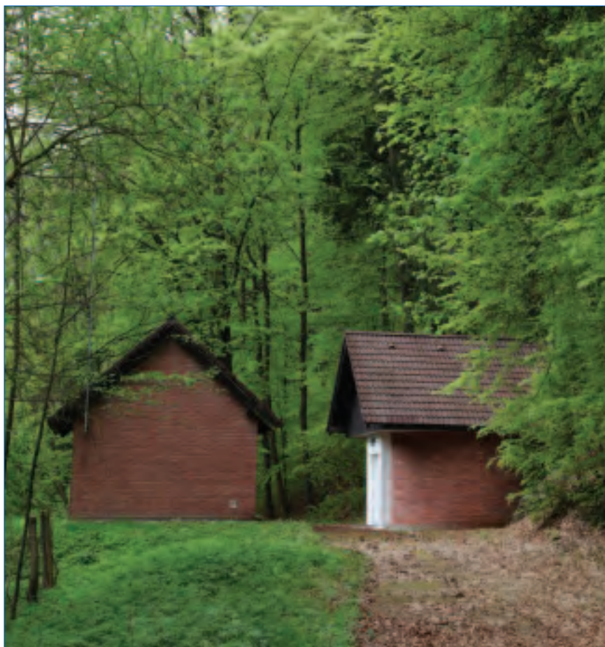
Buřínsko – objekt nad pramenní jímkou (vpravo) a nová čerpací stanice
