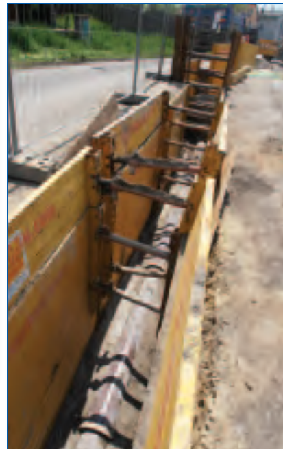
Dobrovice, kanalizace – používání pažicích boxů při výstavbě
