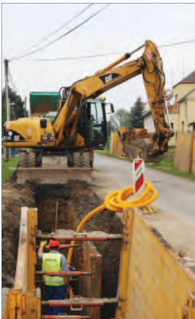
Líny, výstavba splaškové kanalizace
