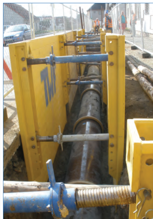
Kněžmost, oprava kanalizace DN 500 mm
