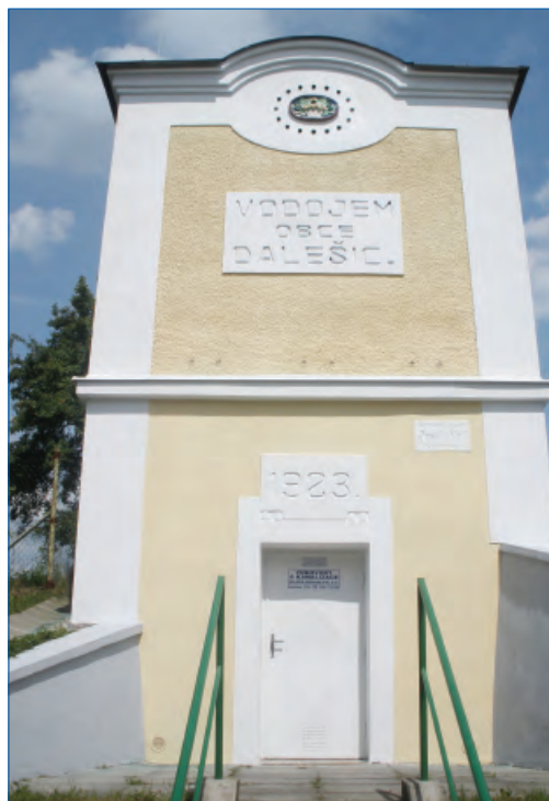
Dalešice, vodojem po opravě fasády
