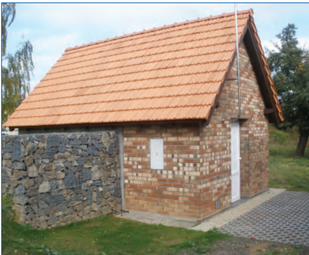
Mukařov, vodojem po rekonstrukci
