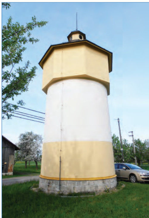
Sedlisko, vodojem po opravě nátěru
