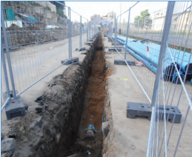
Mladá Boleslav, Ptácká ul., rekonstrukce vodovodu DN 200 mm
