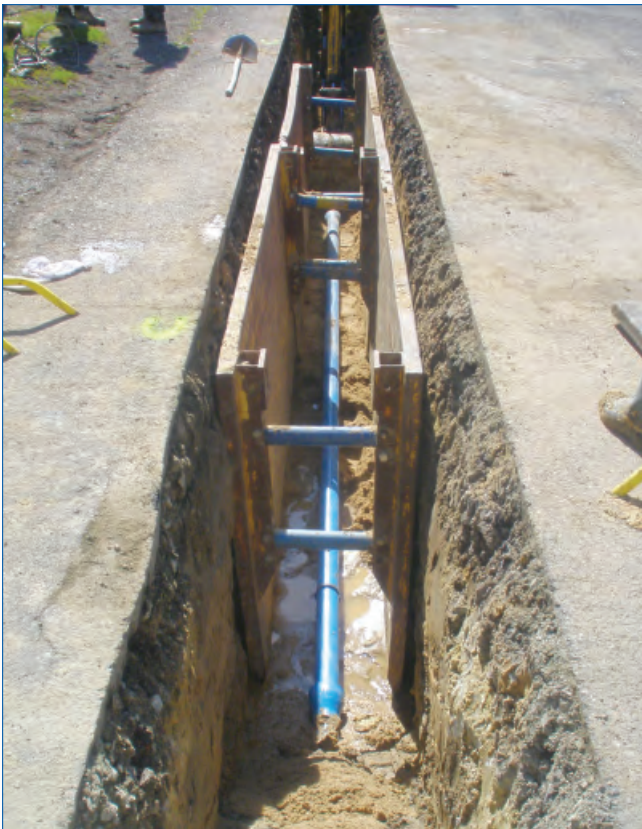
Hrušov, výměna vodovodního řadu
