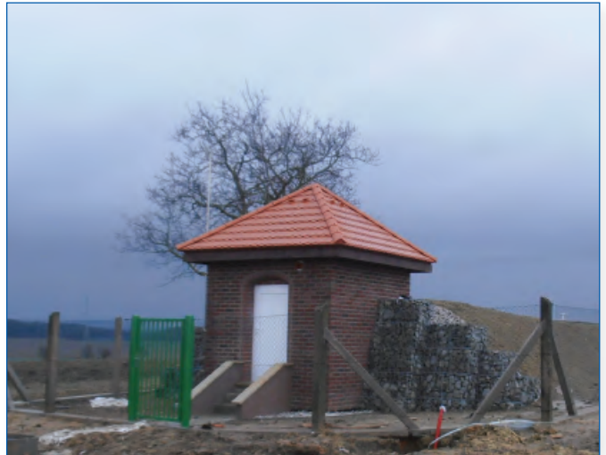
Bitouchov, rekonstrukce zemního vodojemu
