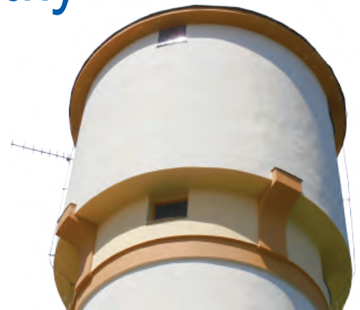
Bílá Hlína, vodojem po opravě nátěru
