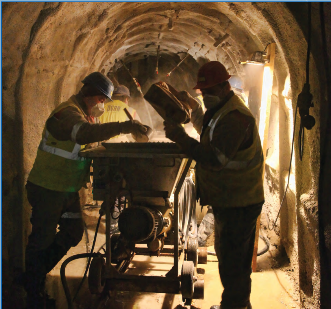
Mnichovo Hradiště, výstavba štoly
