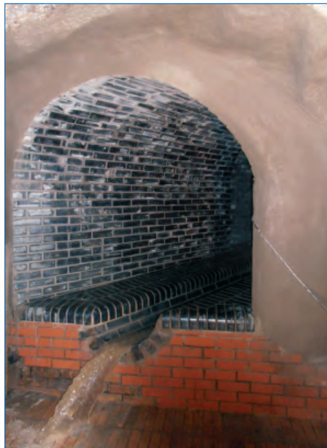
Mladá Boleslav Palackého, vyústění spadiště do štoly
