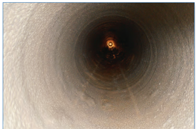
Pohled do vycementované trouby DN 350 mm
