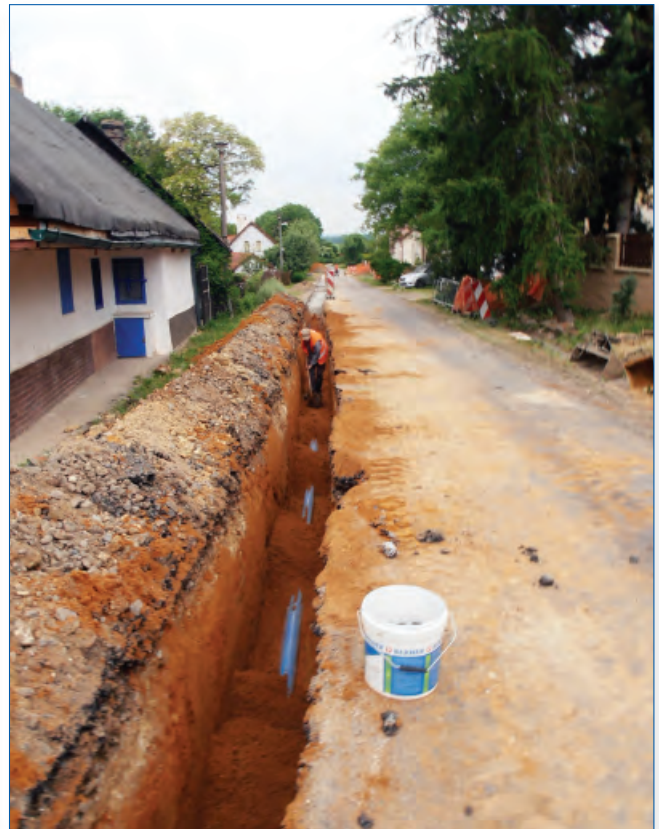
Pětikozly, obnova vodovodu
