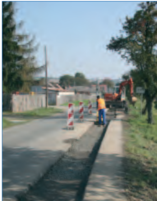
Ledce - stavba přivaděče
