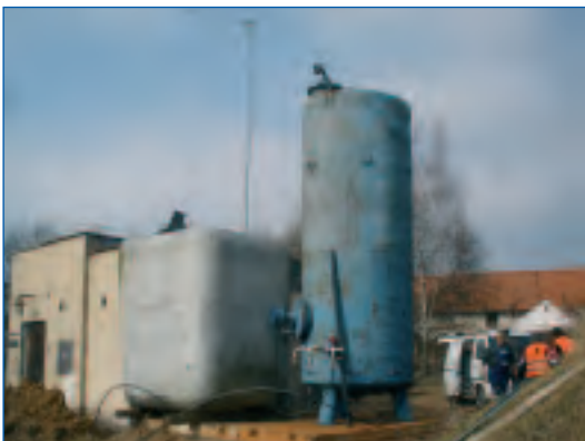
Místo odstaveného vodojemu sloužila během stavby provizorní nádrž.
