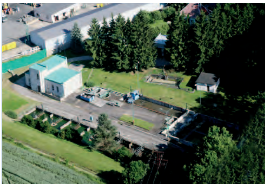
ČOV Mnichovo Hradiště - původní stav
