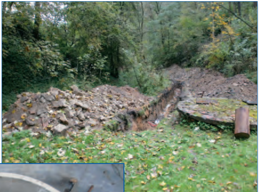
Pokládka vodovodu z Podlázek
