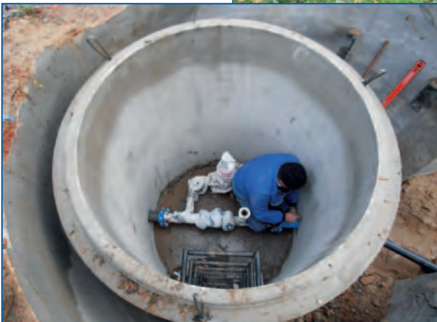
Montáž přečerpací stanice v místě původního zdroje
